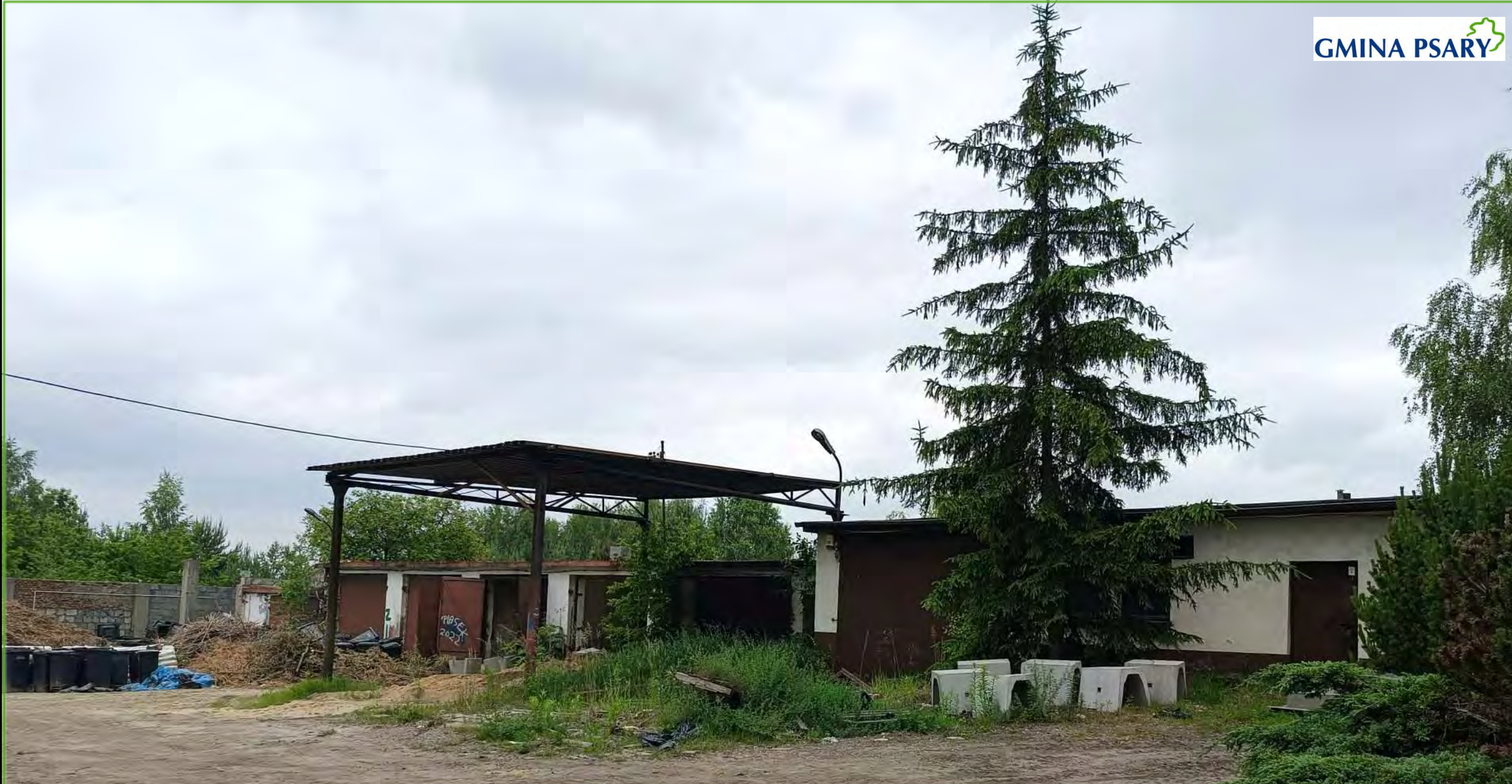
Rekultywacja bazy ZGK przy ul. Pocztowej w Dąbiu
