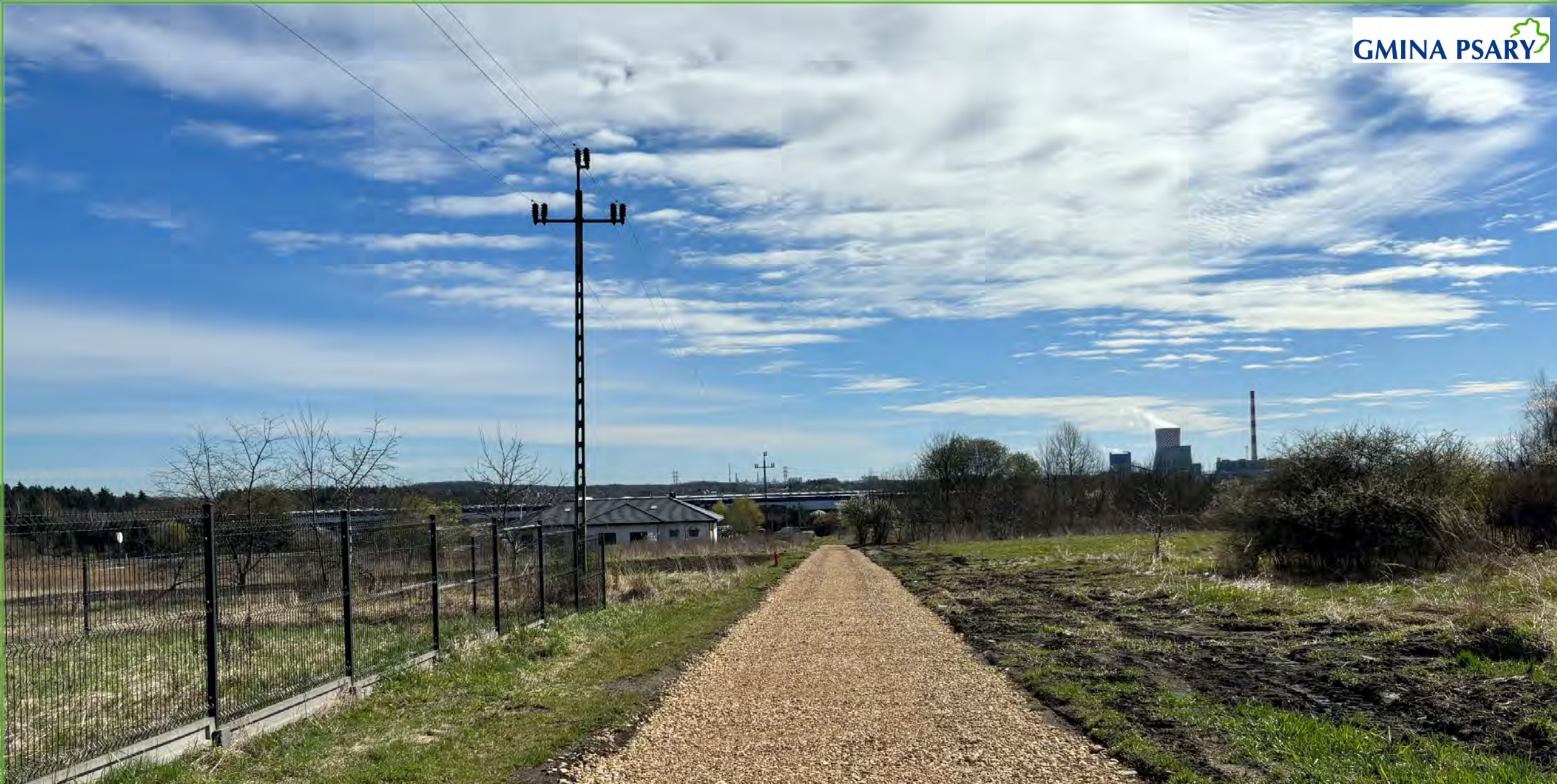
Utwardzenie kruszywem ul. Południowej w Gródkowie
