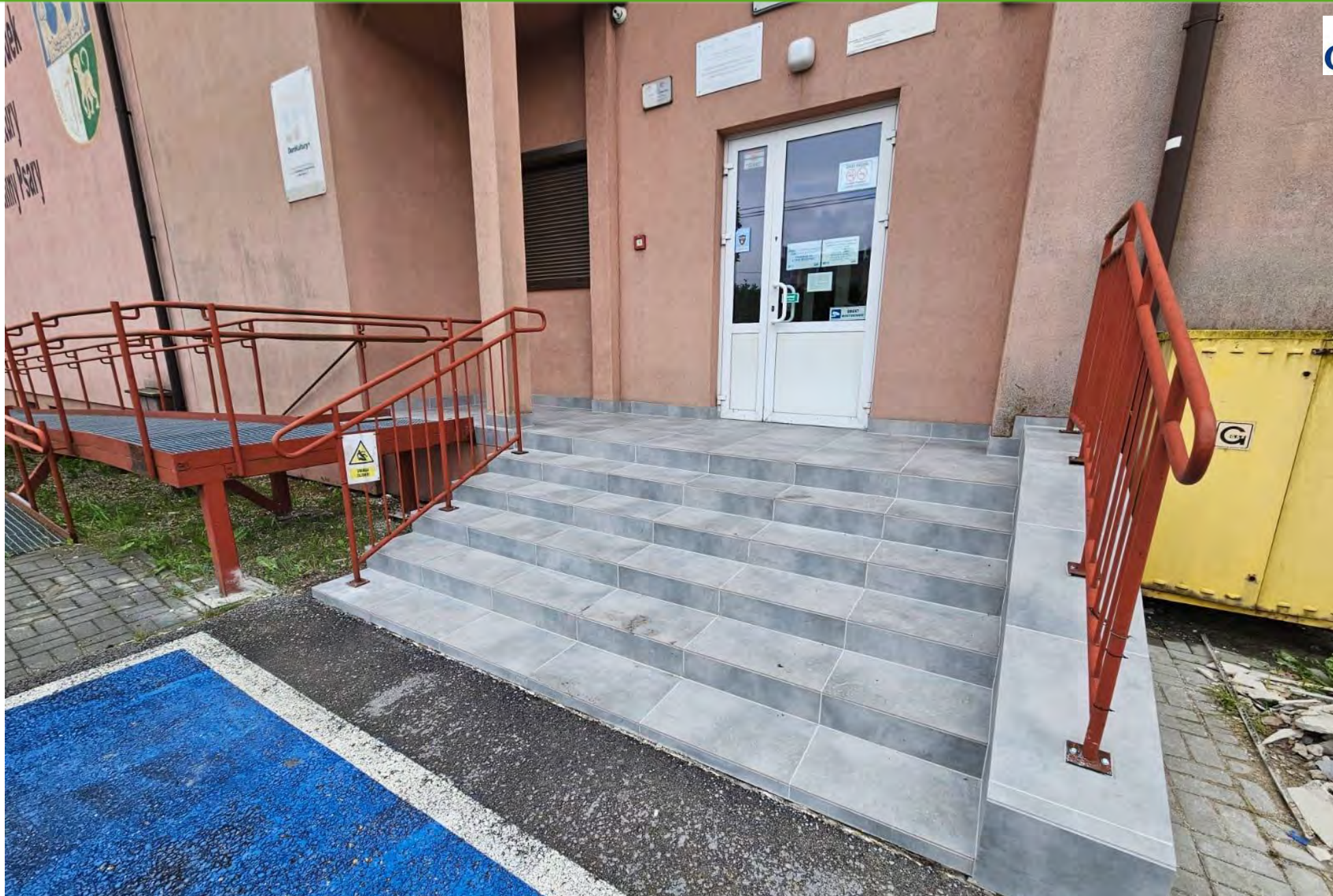
Remont 3 wejść do Gminnego Ośrodka Kultury w Gródkowie
