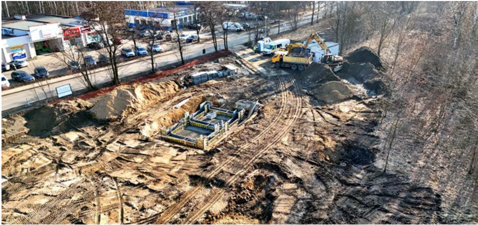
Budowa centrum przesiadkowego w Psarach to jedna z większych inwestycji
