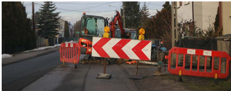
Trwają prace przy budowie wodociągu i kanalizacji
