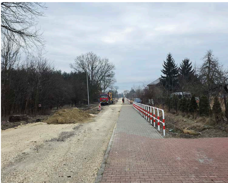
W grudniu prace na ulicy Głównej w Sarnowie zostały wznowione
