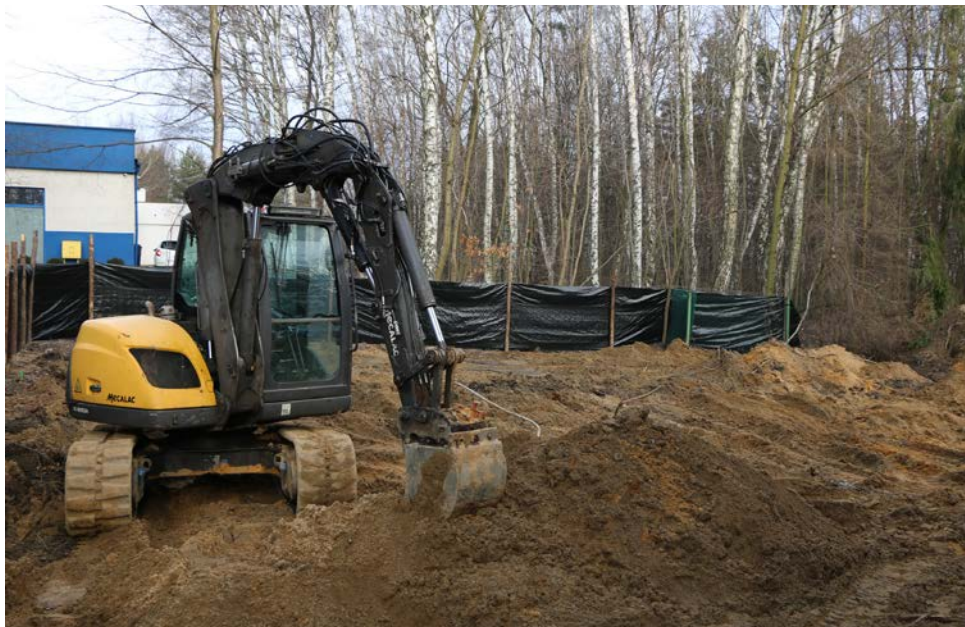
W styczniu rozpoczęły się prace związane z rozbudową urzędu
