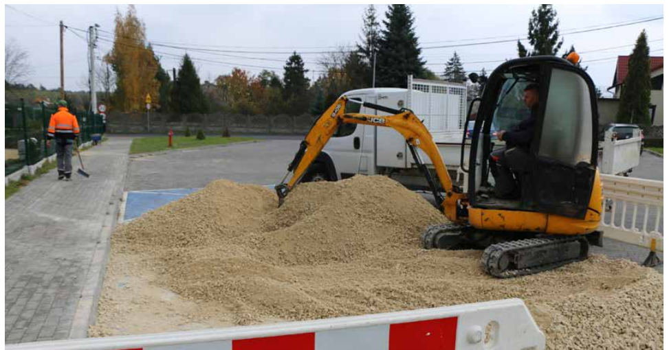
Przy szkole w Gródkowie rozpoczęły się prace nad budową chodnika
