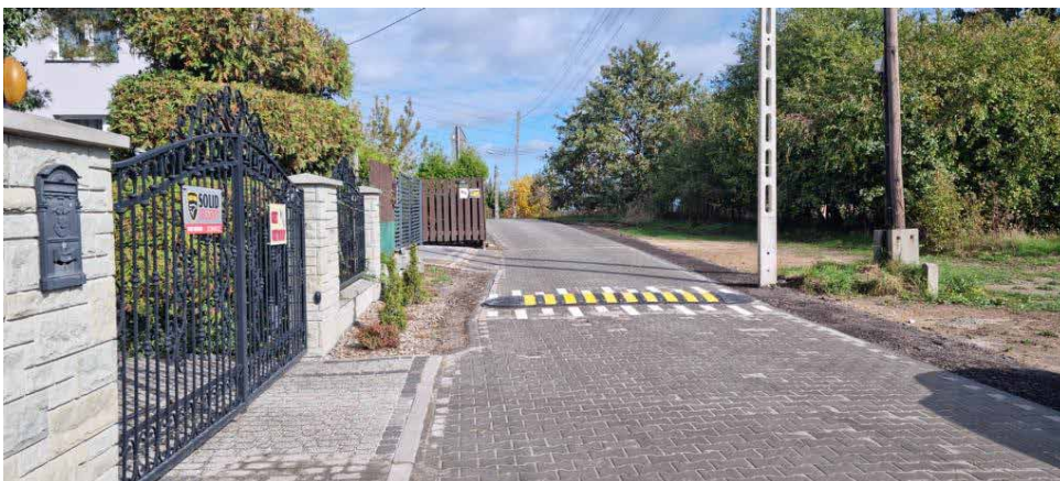
Na 240 m odcinku drogi pojawiła się nawierzchnia z kostki betonowej
