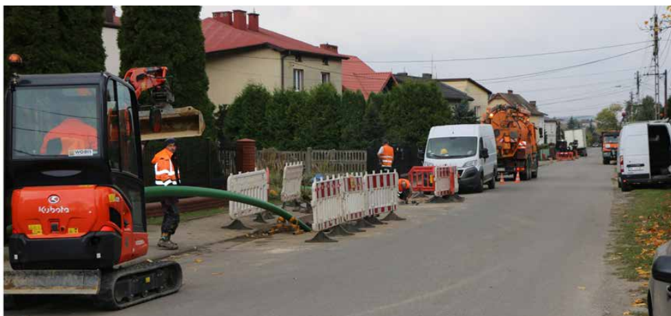
Prace częściowo prowadzone są metodą przewiertu sterowanego
