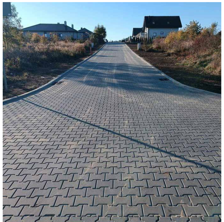
Na ulicy Dolomitowej w Górze Siewierskiej zostało ułożone 200 m nawierzchni z kostki brukowej
