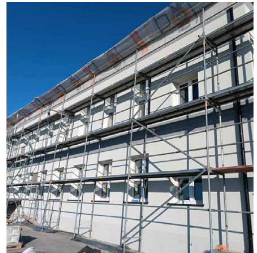
Prace przy remoncie elewacji dobiegają końca
