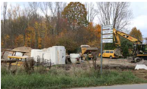
PRACE PRZY BUDOWIE CENTRUM PRZESIADKOWEGO W PSARACH
