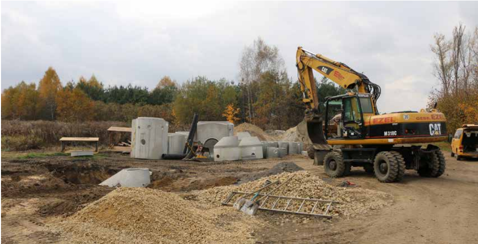
Prace przy budowie centrum przesiadkowego trwają
