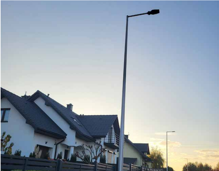
Na terenie 7 sołectw trwają prace nad budową oświetlenia ulicznego
