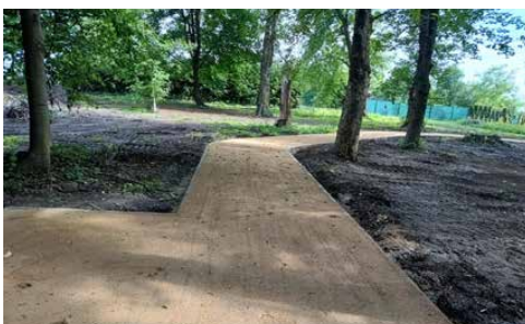
ROZPOCZĘŁY SIĘ PRACE W PARKU PRZY ULICY REYMONTA W PSARACH
