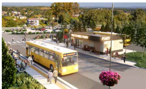
RUSZA BUDOWA CENTRUM PRZESIADKOWEGO W PSARACH
