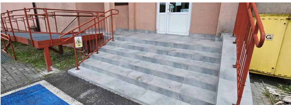
Schody przy wejściu głównym pokryte zostały płytkami
