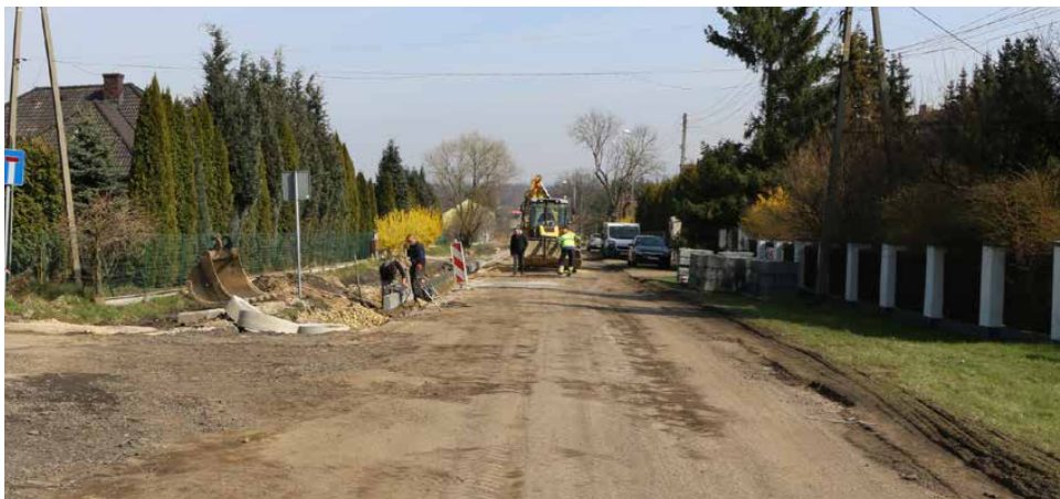
Nowa nawierzchnia asfaltowa pojawi się na 840 m odcinku ulicy Wiejskiej w Sarnowie
