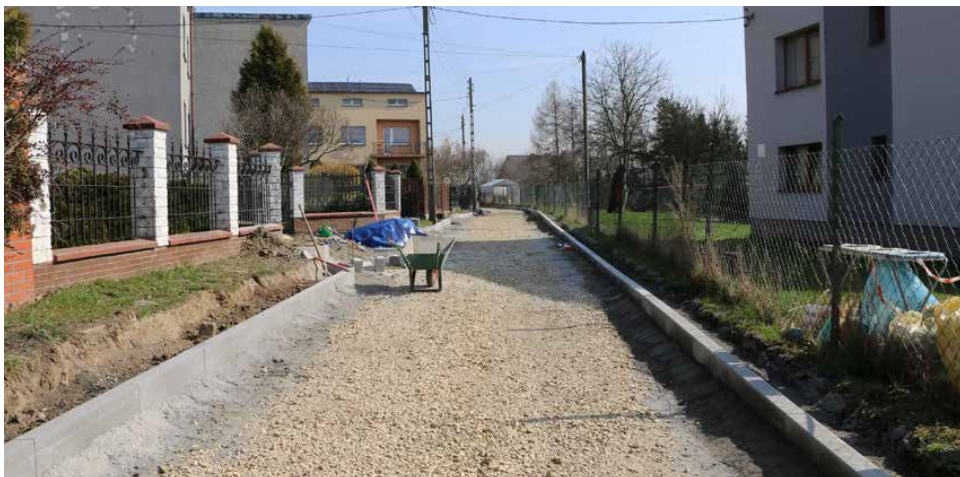
Na ulicy Cichej w Strzyżowicach wykonano już częściową podbudowę drogi
