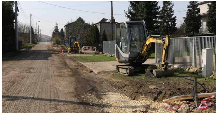
Aktualnie wymieniany jest 200 m odcinek wodociągu
