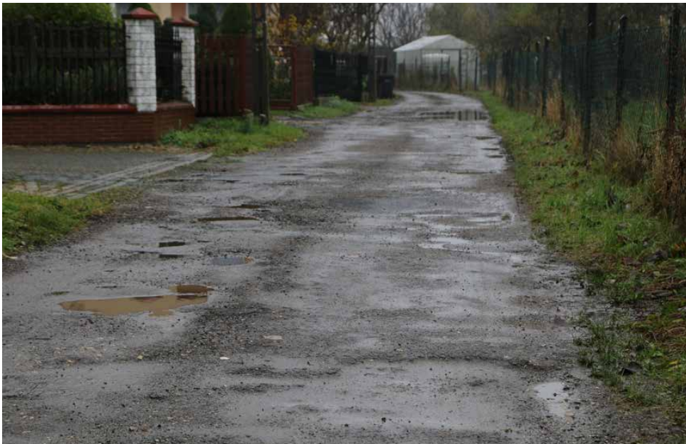
Prace na ulicy Cichej w Strzyżowicach potrwać do końca maja 2024 roku
