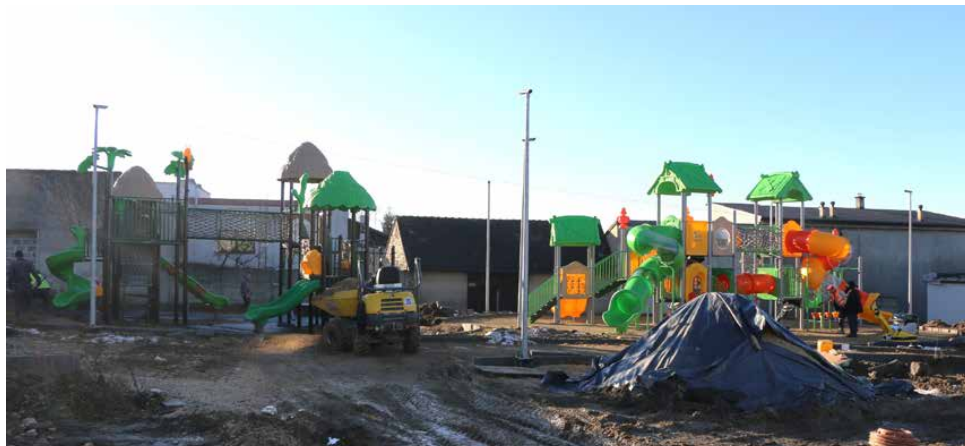
Teren za remizą OSP i Ośrodkiem Kultury w Górze Siewierskiej już w przyszłym roku będzie służył mieszkańcom
