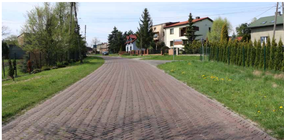
W Sarnowie powstanie prawie 1 km nowej drogi asfaltowej wraz z chodnikiem
