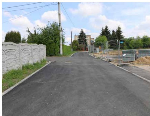
W ramach prac wybudowano kanalizację deszczową
