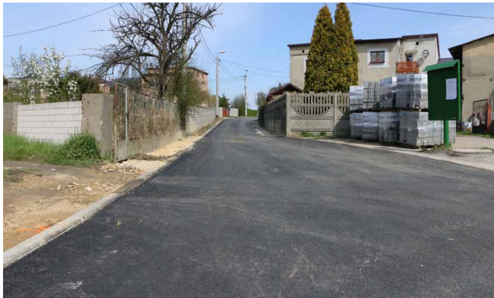
Na ulicy Ogrodowej położono blisko 143 m nowego asfaltu
