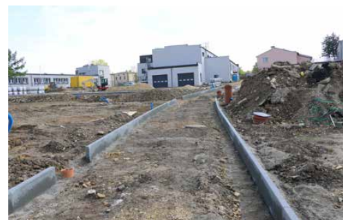
Powstaje chodnik łączący ulicę Ogrodową z ulicą Szopena
