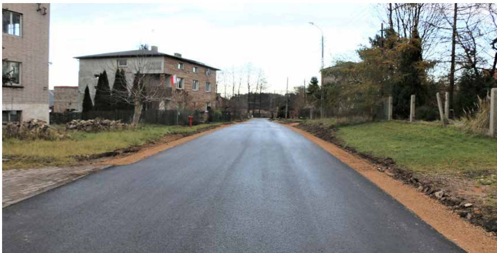
Na 1,4 km odcinku drogi powstała nowa nawierzchnia z betonu asfaltowego
