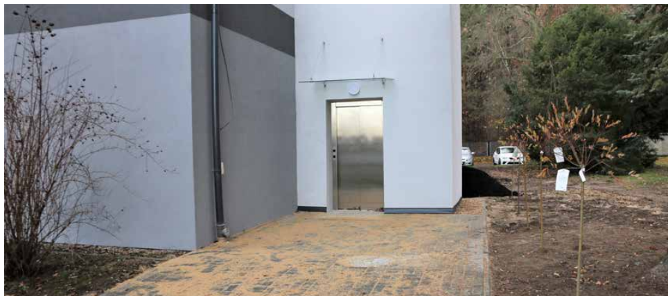
Winda stanęła po prawej stronie budynku Gminnego Centrum Medycznego
