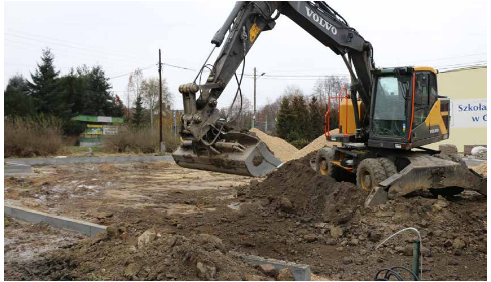
Po budowie sali gimnastycznej przyszedł czas na nowy parking
