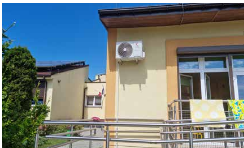
KLIMATYZACJA W KOLEJNYCH GMINNYCH OBIEKTACH
