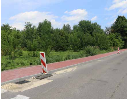
Nowy chodnik na odcinku ul. Głównej w Sarnowie
