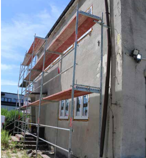
Wykonawca rozpoczął już ocieplanie ścian budynku
