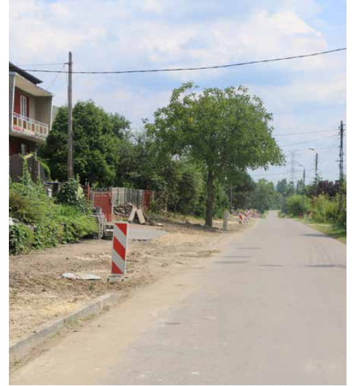
Trwa budowa chodnika przy ulicy Dolnej w Dąbiu
