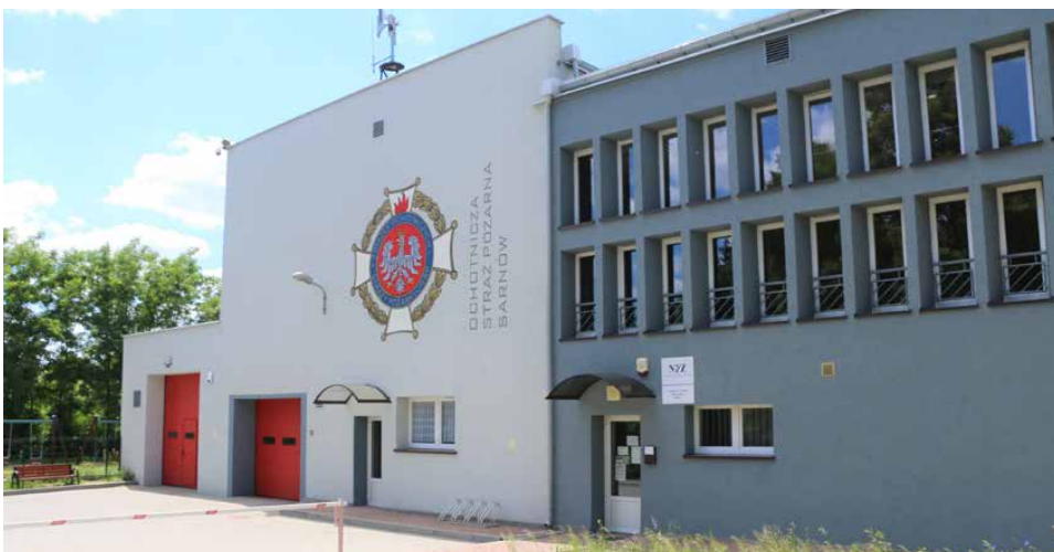
W ubiegłym roku został zmodernizowany budynek OSP w Sarnowie
