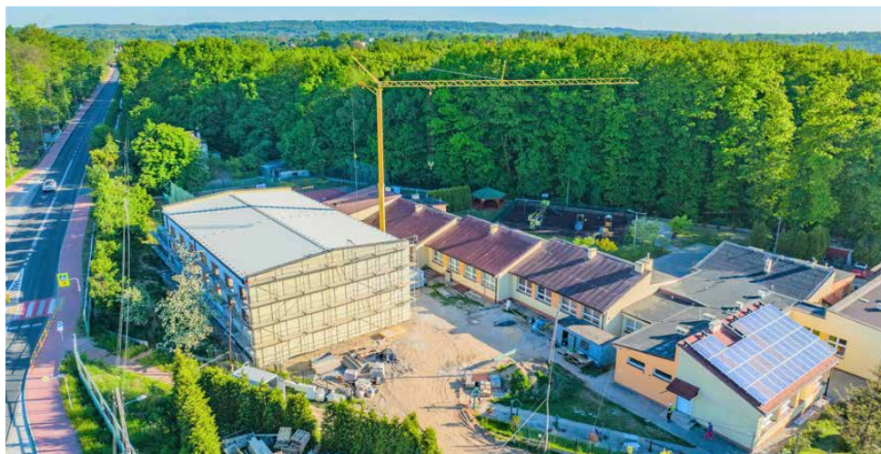
Wiosną 2021 roku rozpoczęła się budowa sali gimnastycznej przy szkole w Gródkowie
