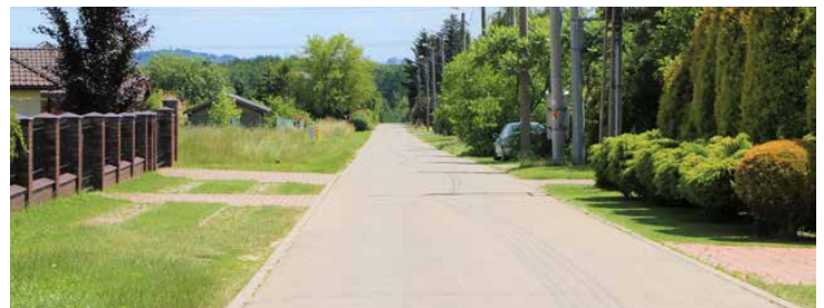
Budowa odwodnienia ul. Leśnej w Sarnowie to koszt ponad 350 tys. zł
