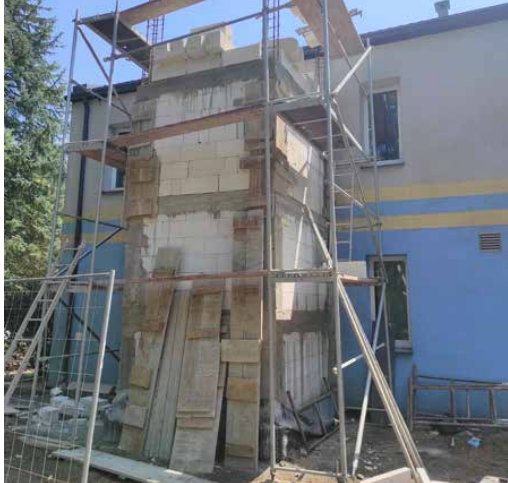
Winda powstaje na zachodniej stronie budynku
