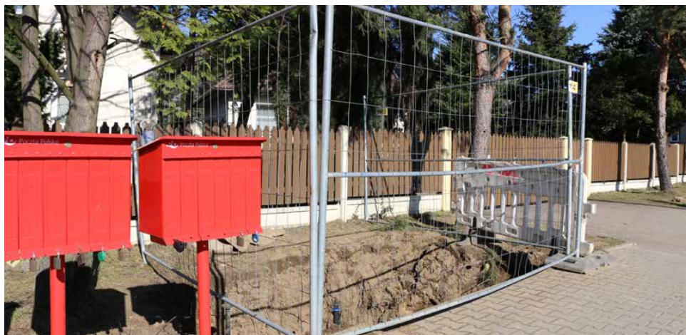
Prace przy budowie wodociągu zakończyły się w maju
