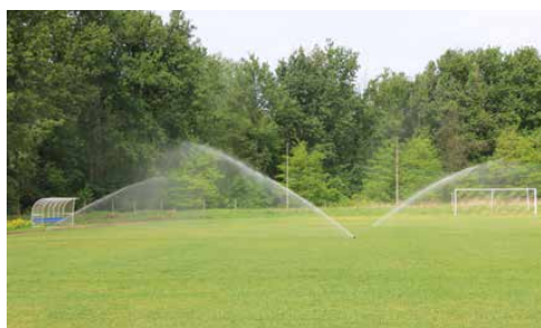
AUTOMATYCZNE NAWADNIANIE NA STADIONIE W GÓRZE SIEWIERSKIEJ
