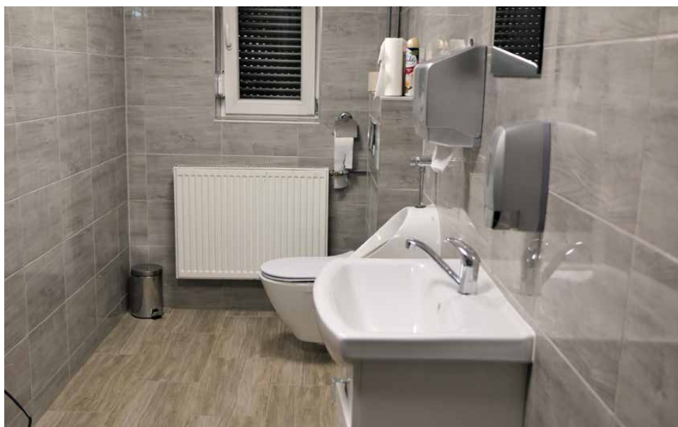
Na ścianach i podłogach pojawiły się nowe płytki
