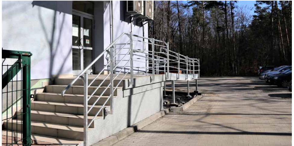
Przy urzędzie została zamontowana pochylnia ułatwiająca dostanie się do budynku osobom z niepełnosprawnościami
