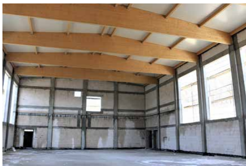
Sala gimnastyczna w Gródkowie została zadaszona
