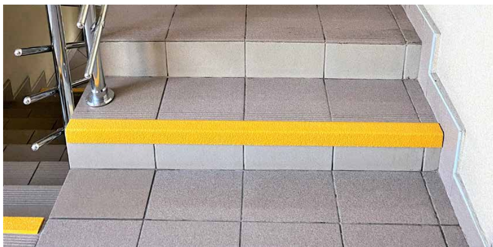
Na schodach pojawiły się taśmy antypoślizgowe wykonane z miękkiego PCV
