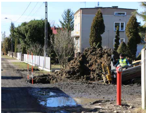
Prace prowadzone są wykopem otwartym i przewiertem sterowanym
