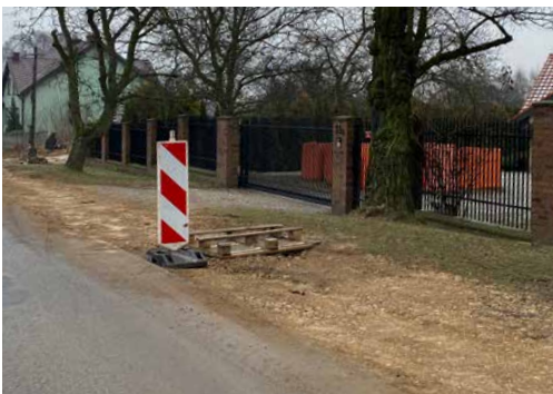
W Goląsży Bisce powstaje ponad 1 km nowego chodnika
