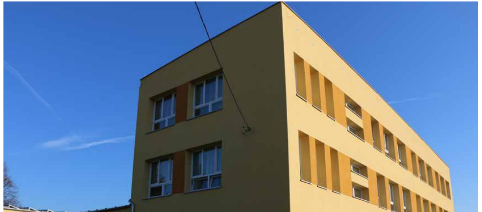
Szkoła w Strzyżowicach przeszła termomodernizację
