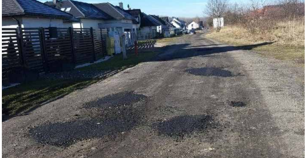
Jedną z naprawianych ulic była ul. Słoneczna w Malinowicach
