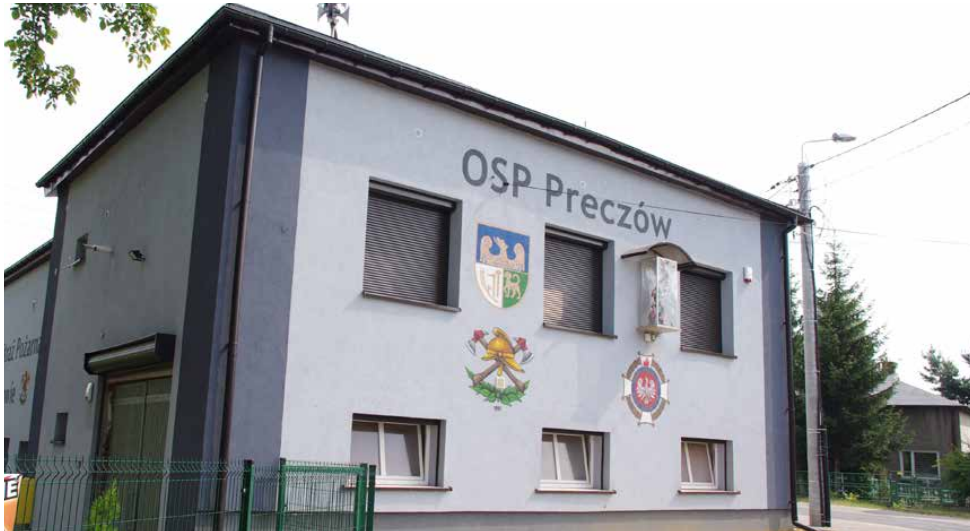
Jeden z wniosków dotyczy rozbudowy Ośrodka Kultury i OSP w Preczowie
