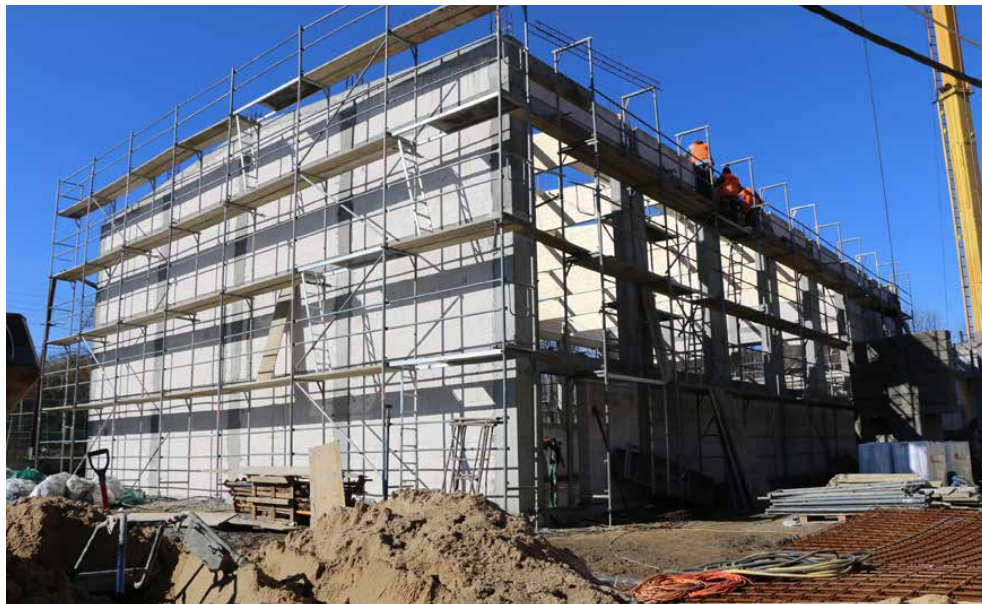
Wymurowano już ściany nowej sali gimnastycznej
