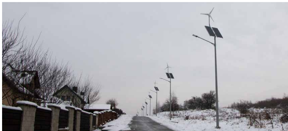
Na ul. Irysów w Psarach zamontowano oświetlenie hybrydowe
