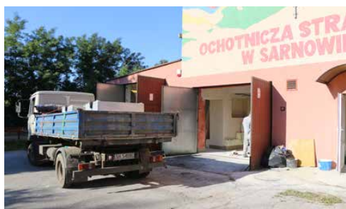
RUSZYŁA MODERNIZACJA BUDYNKU OSP W SARNOWIE
