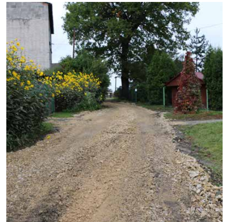
Prace prowadzone są m.in. w Malinowicach
