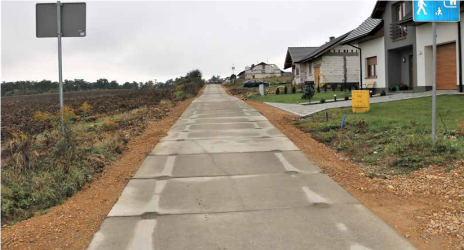
Na ul. Bazaltowej w Górze Siewierskiej wykonano nawierzchnię z płyt betonowych
