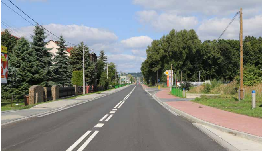
DW 913 to nowa droga z pełną podbudową
