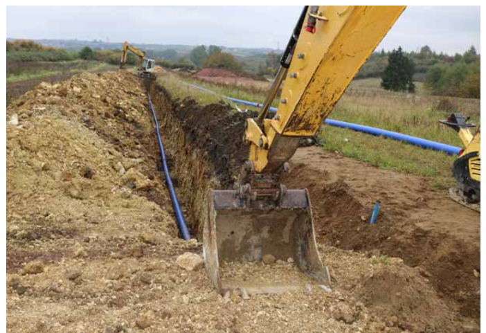
Prace wykonywane są obecnie w Górze Siewierskiej przy ul. Złotej
