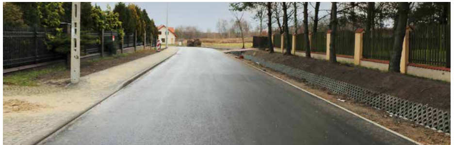
Inwestycja objęła ponad 400 m drogi
