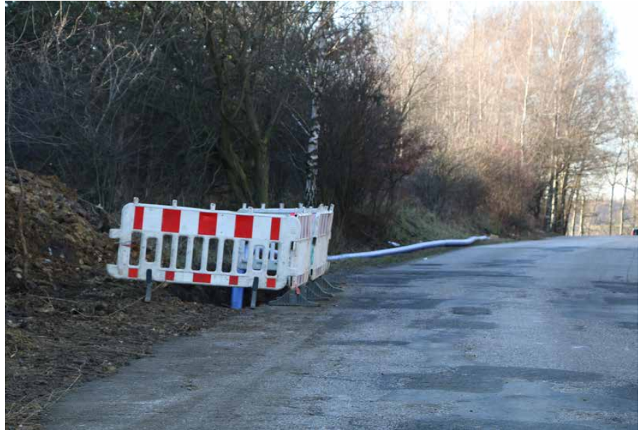
Łącznie przebudowa obejmie ok. 3 km sieci
