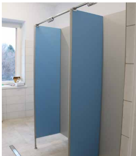
W szkole w Dąbiu wyremontowano sanitariaty
