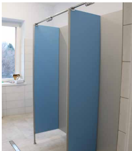
W szkole w Dąbiu wyremontowano sanitariaty
