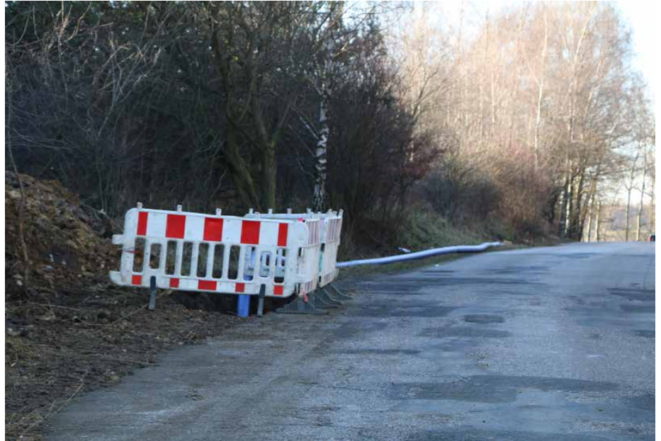
Łącznie przebudowa obejmie ok. 3 km sieci
