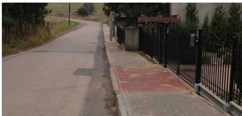
Nowy odcinek chodnika przy ul. Leśnej w Górze Siewierskiej
