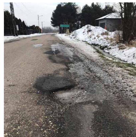
Ulica Brzozowa w Malinowicach przejdzie kompleksową przebudowę
