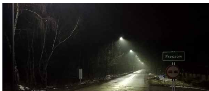
Nowe oświetlenie na odcinku ulicy Dębowej w Preczowie
