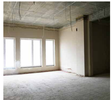
Rozprowadzane są m.in. instalacje elektryczne
