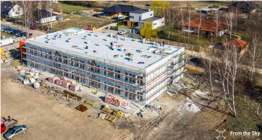
Trwa docieplanie elewacji budynku
