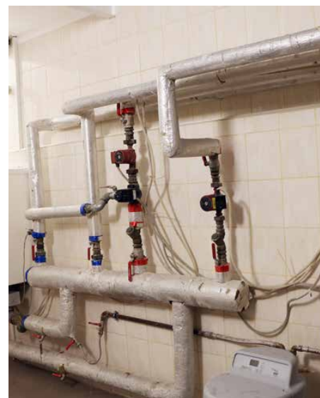
Wyremontowane pomieszczenie remizy OSP Psary
