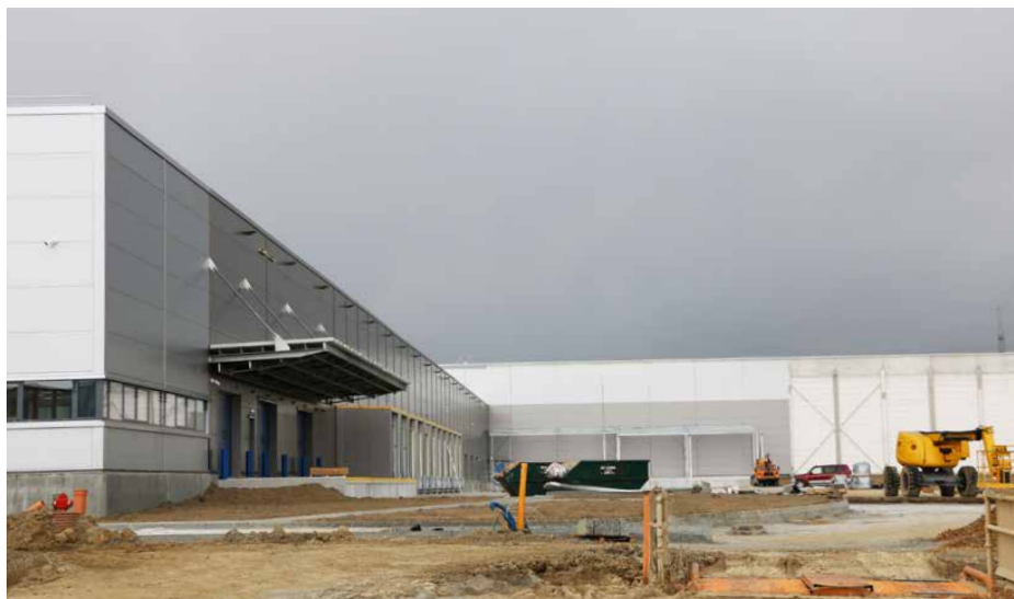
Budowa kolejnej hali FM Logistic zmierza ku końcowi
