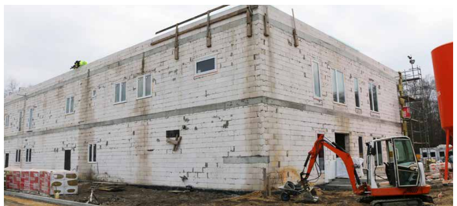
W placówce zamontowano już okna
