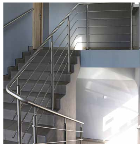
Nowa balustrada w ośrodku w Strzyżowicach
