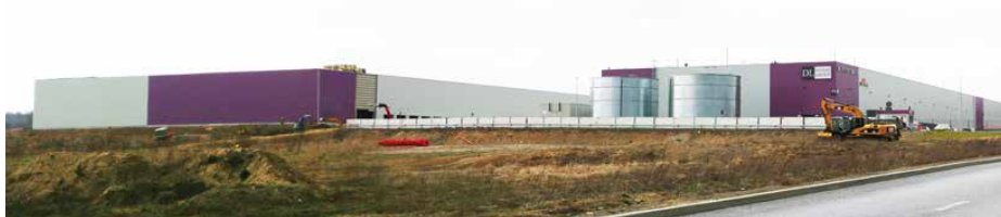
Firma DL Invest kończy budowę drugiego obiektu magazynowego
