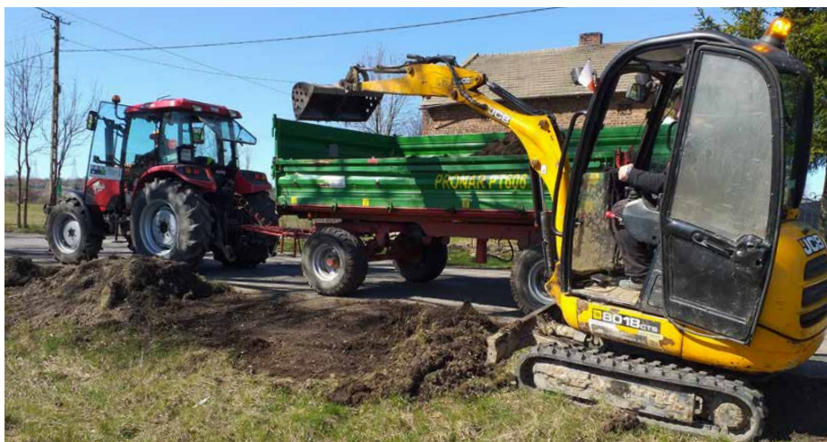
Na ul. Starej w Sarnowie prace obejmują m.in. odtworzenie rowów odwadniających
