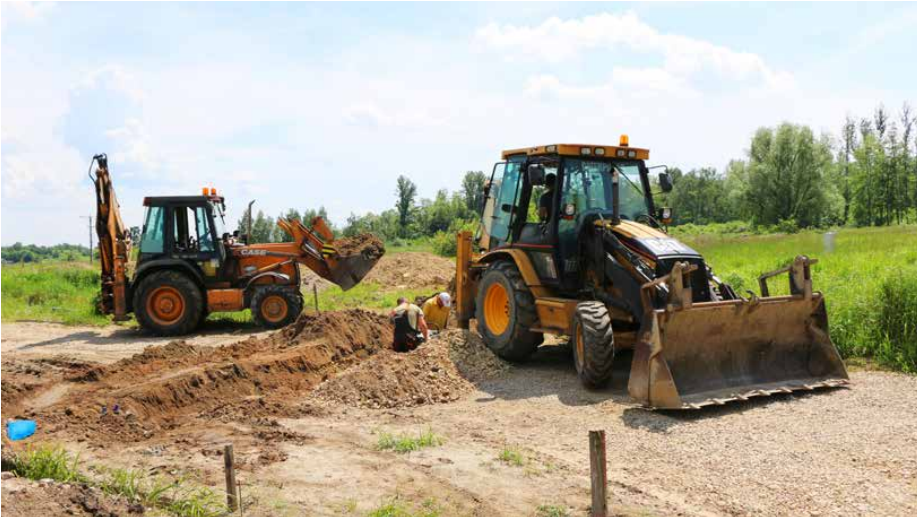
Budowa wodociągu na Osiedlu Malinowice II w drugiej linii zabudowy
