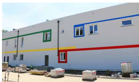
BUDOWA ŻŁOBKA I PRZEDSZKOLA W PSARACH ZMIERZA KU KOŃCOWI
