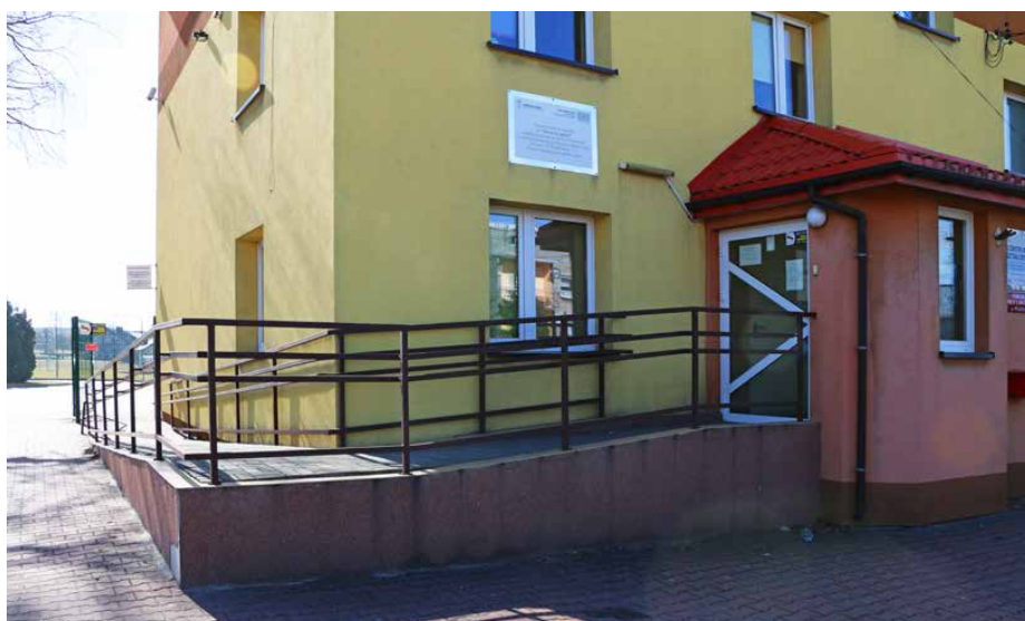
Do budynku prowadzi specjalny podjazd dla wózków inwalidzkich
