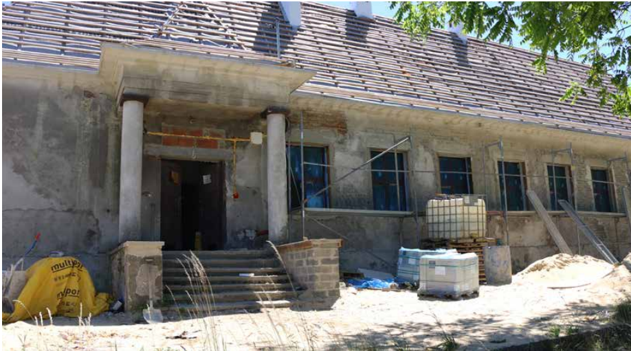
Trwa wymiana stolarki okiennej
