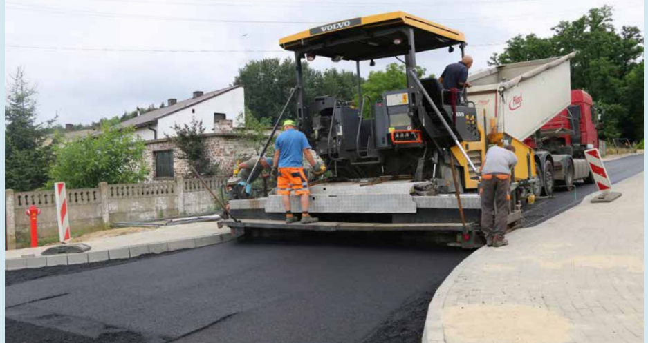
Przebudowa obejmuje blisko 300 m odcinek gminnej drogi
