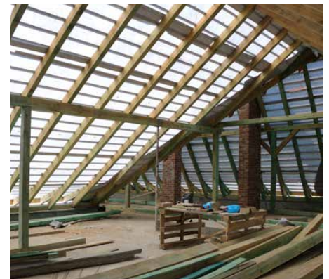
W budynku pojawiła się nowa więźba
