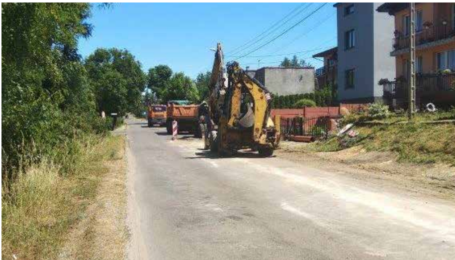
Budowa chodnika w Górze Siewierskiej na ul. Kościuszki
