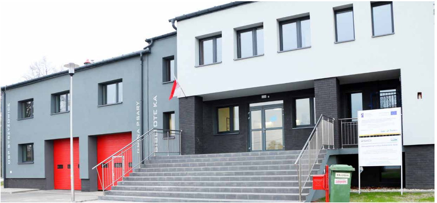
Placówka przeszła kompleksowy remont wewnątrz i na zewnątrz
