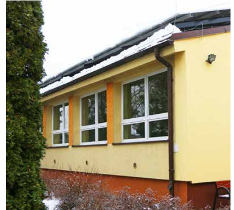
Panele fotowoltaiczne na dachu szkoły w Gródkowie
