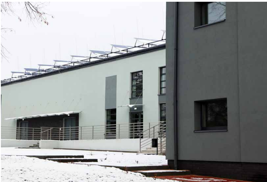
Na dachu budynku zamontowano panele fotowoltaiczne
