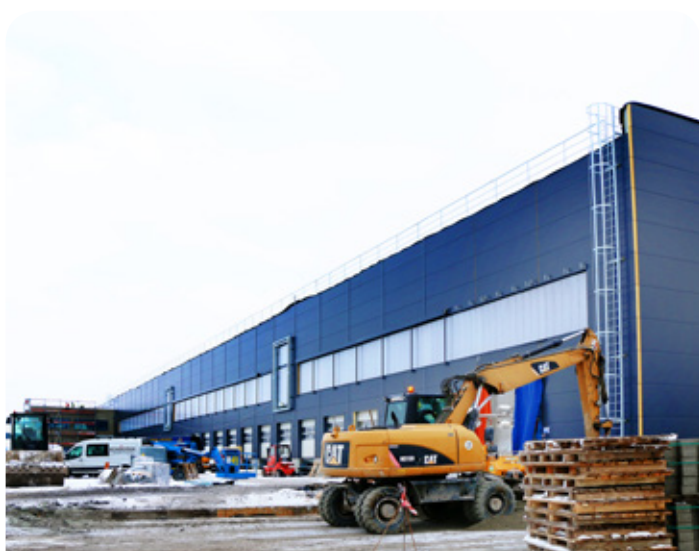
20 czerwca ruszyły pierwsze prace związane z budową centrum logistycznego LIDL w gminie Psary, inwestycja ta jest warta 119 mln zł, prace zakończą się wiosną bieżącego roku. Lidl Polska w centrum logistycznym w Gródkowie będzie zatrudniała ponad 200 osób.
