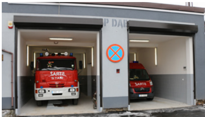
Stare drzwi garażowe zastąpiono automatycznie podnoszonymi
