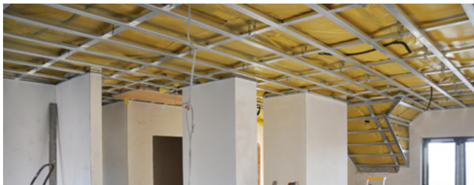
Ocieplenie dachu w budynku mieszkalnym beneficjentów programu. Fot. M. Śledź
