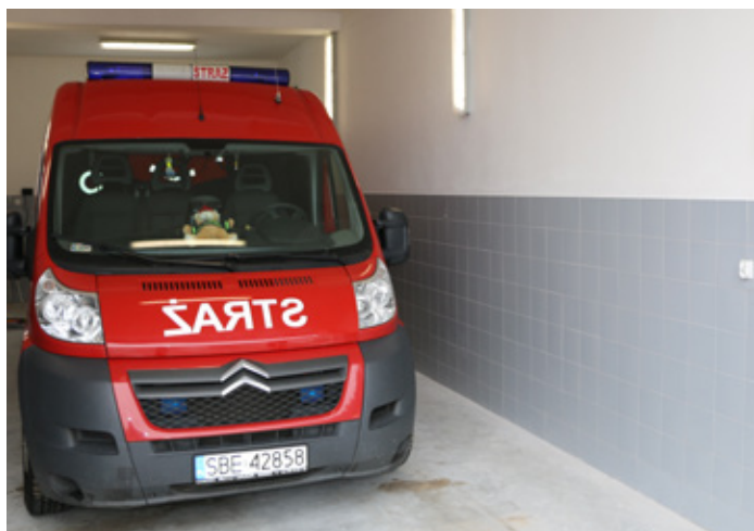
Wnętrze jednego z dwóch wyremontowanych garaży
