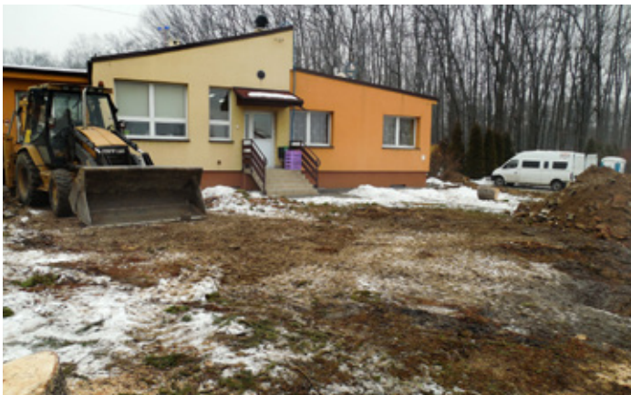
Prace przy szkole podstawowej w Gródkowie
