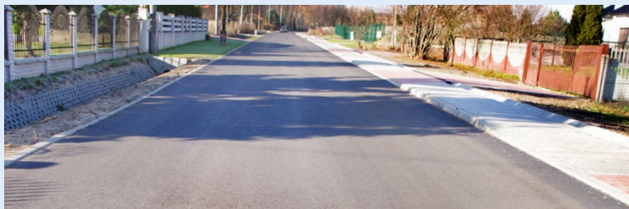
W zeszłym roku przebudowano ponad kilometr głównej drogi w Preczowie
