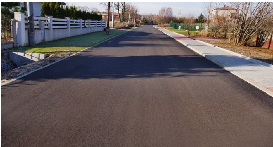
Nowy asfalt oraz chodnik na ulicy Szkolnej w Preczowie
