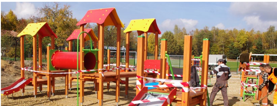
Montaż urządzeń na placu zabaw na terenie stadionu
