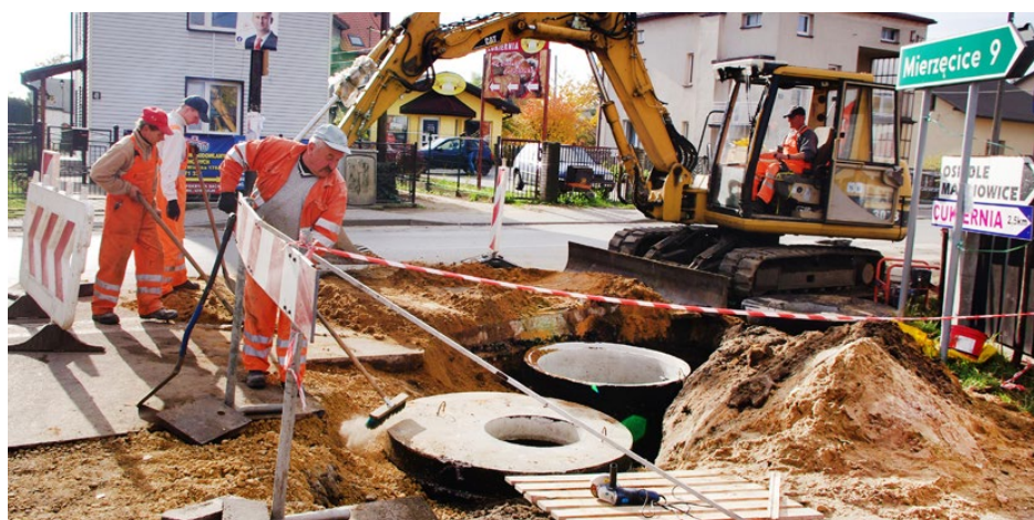
Prace nad budową chodnika na ul. Malinowickiej w Psarach
