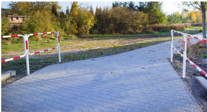
Chodnik pomiędzy DK86 a ul. Szkolną w Sarnowie
