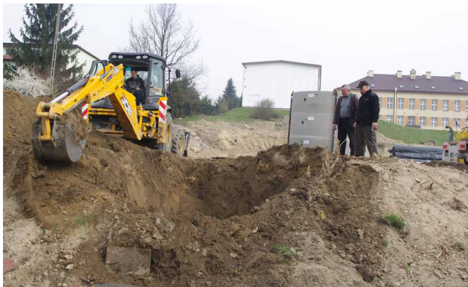
Prace podczas osadzania studzienek kanalizacji deszczowej
