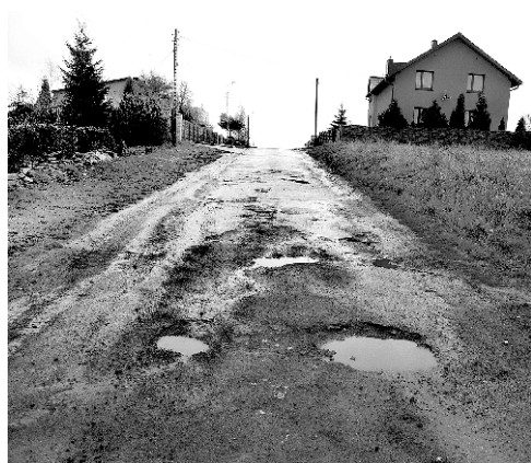
W 2014r. zostanie wykonana kompleksowa przebudowa ul. Kościuszki w Górze Sierwierskiej
