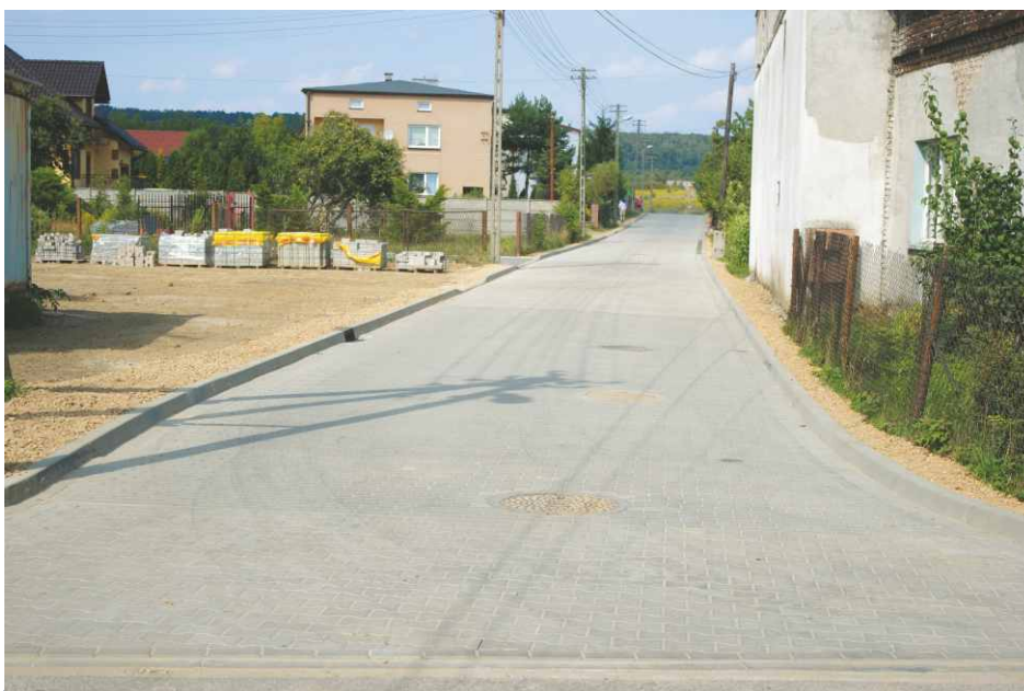
Na ul. Bocznej w Strzyżowicach i Zielonej w Preczowie powstaną drogi z kostki betonowej tak jak na wybudowanej w 2012r. ulicy Kaszsztanowej w Psarach
