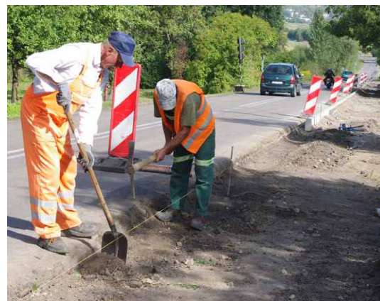
Budowa chodnika w Malinowicach.
