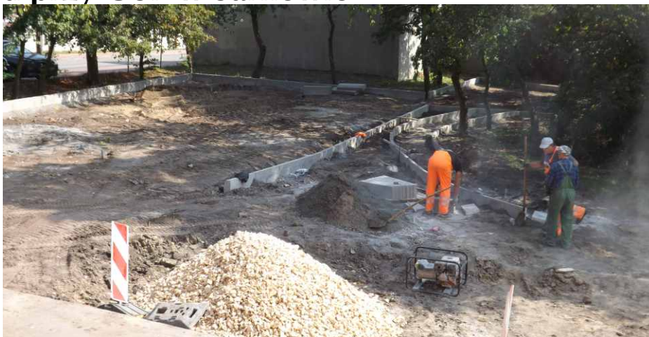
Prace przy wykonywaniu krawężników.
