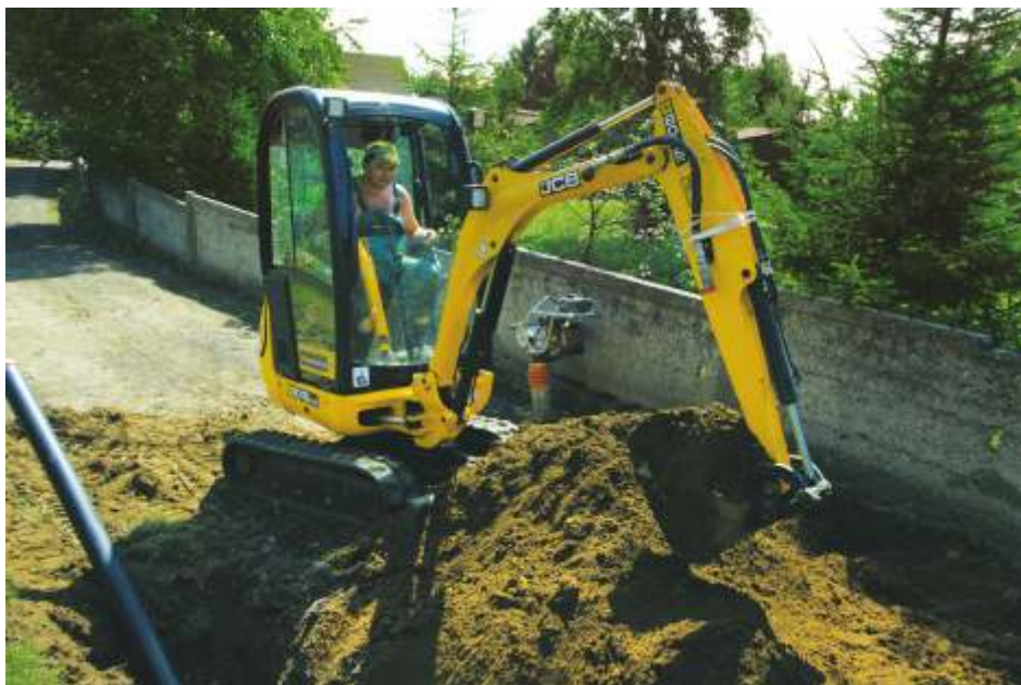
Zakład Gospodarki Komunalnej wymienił ponad 3 km wodociągu.
