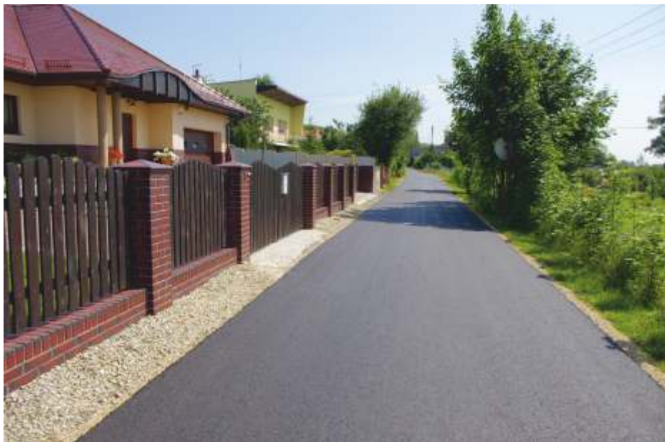
Nowa nakładka asfaltowe na ul. Podwale w Strzyżowicach.
