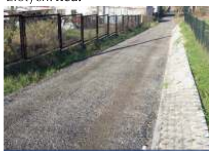
Droga do boiska w Gołąszy Górnej utwardzona frezem asfaltowym.
