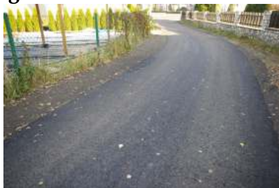
Ulica Ogrodowa w Strzyżowicach po remoncie.
