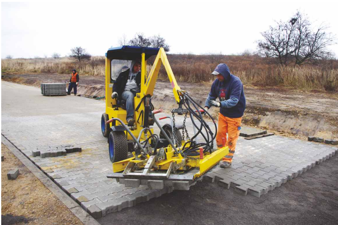
Prace nad układaniem kostki brukowej na ulicy Irysów w Psarach.
