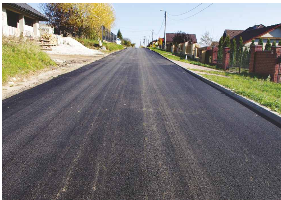
Nowa nakładka asfaltowa na ul. Górnej w Górze Siewierskiej.
