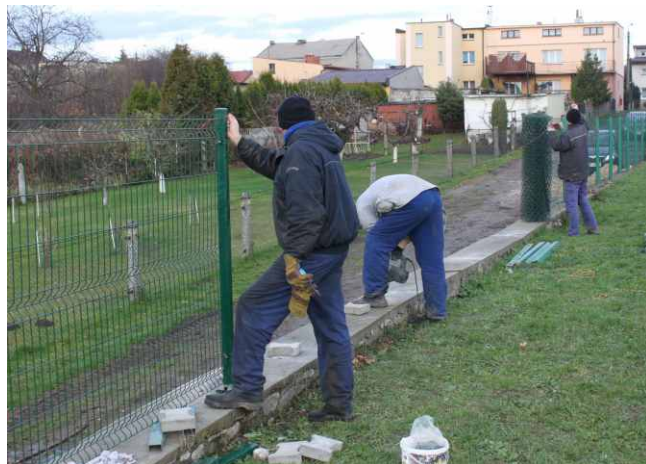
Prace nad wymianą ogrodzenia.
