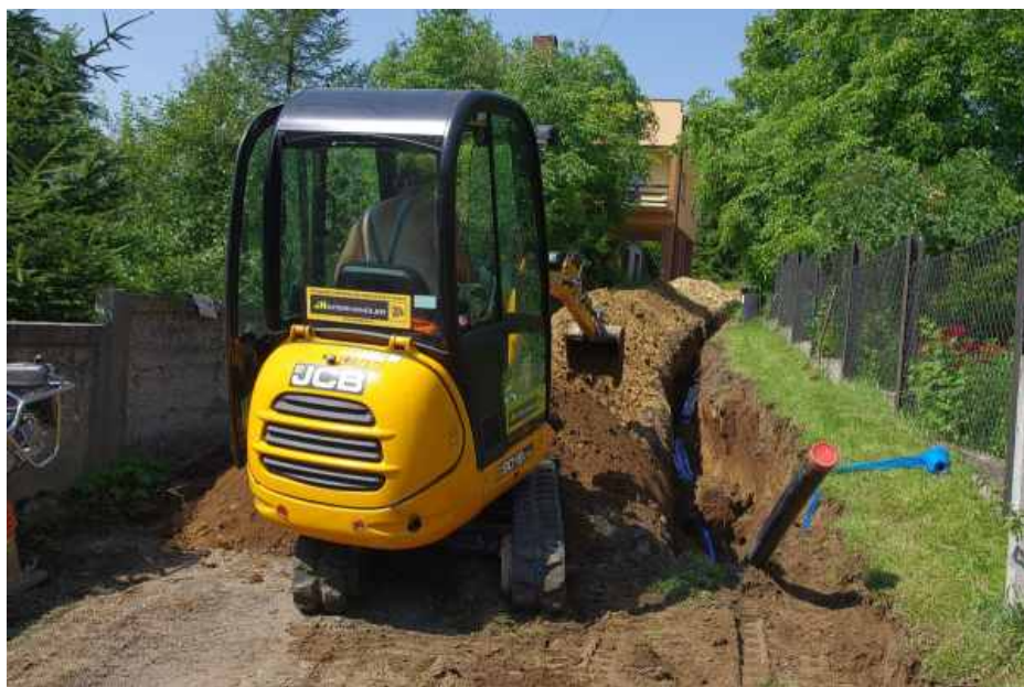
Nowa minikoparka ułatwia prace na wąskiej ul. Ogrodowej
