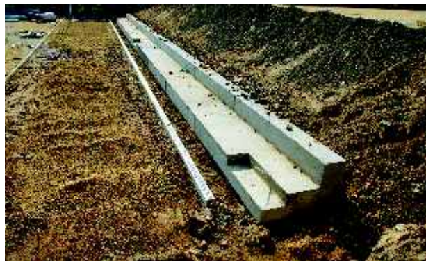
Mur oporowy jednocześnie stanowi konstrukcję pod dwustopniową widownię przy mniejszym boisku.
