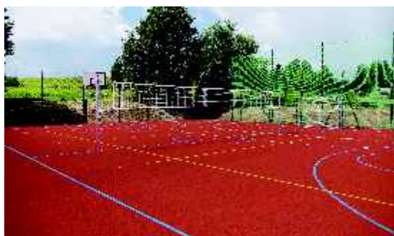
Od połowy lipca boisko wielofunkcyjne w Malinowicach jest otwarte dla amatorów sportu.
