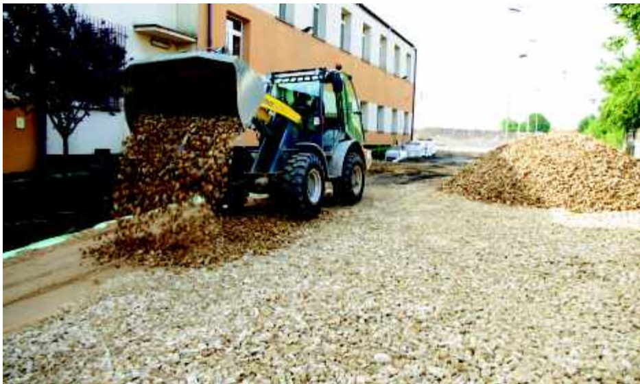
Prace przy podbudowie drogi prowadzącej do kompleksu boisk.
