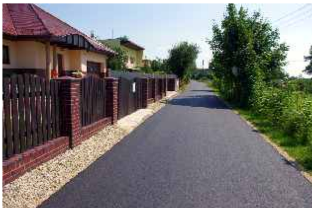
Nowa nakładka asfaltowa na ul. Podwale w Strzyżowicach.
