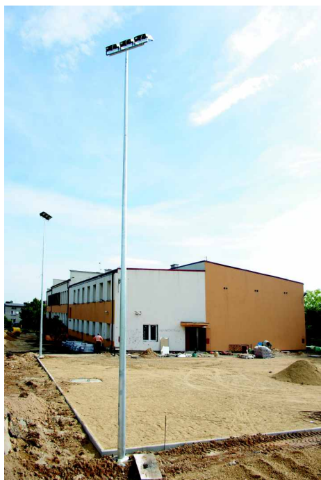
Przy boiskach zamontowano oświetlenie, na mniejszym - wielofunkcyjnym do koszykówki i siatkówki wkrótce zostanie wyłożona bezpieczna nawierzchnia.
