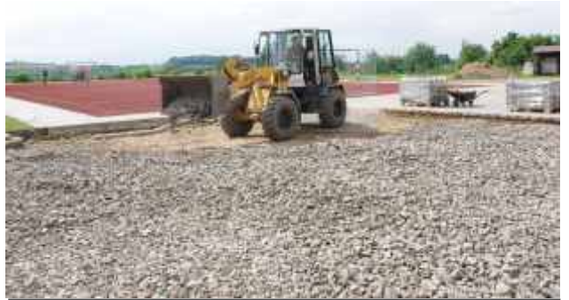
Prace przy podbudowie placu zabaw.
