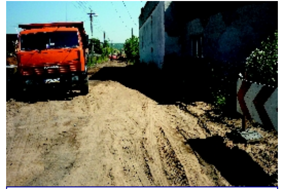
Prace na ul. Kasztanowej w Psarach.
