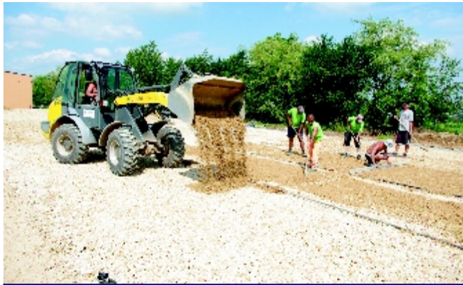
Na boisku Orlika wykonywana jest podbudowa.
