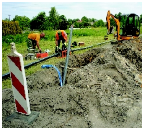
Prace przy budowie wodociągu w Preczowie na ulicy Brzeźnej.
