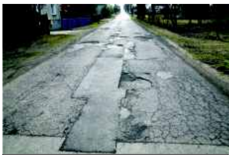
Ulica Graniczna przed remontem.
