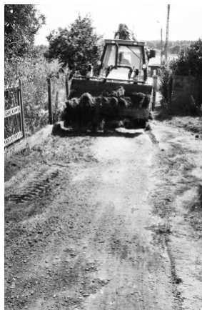
Prace na ulicy Wąskiej.
