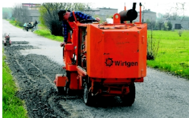
Jeden z pracowników firmy „Drogrem” podczas uzupełniania ubytków w drodze.
