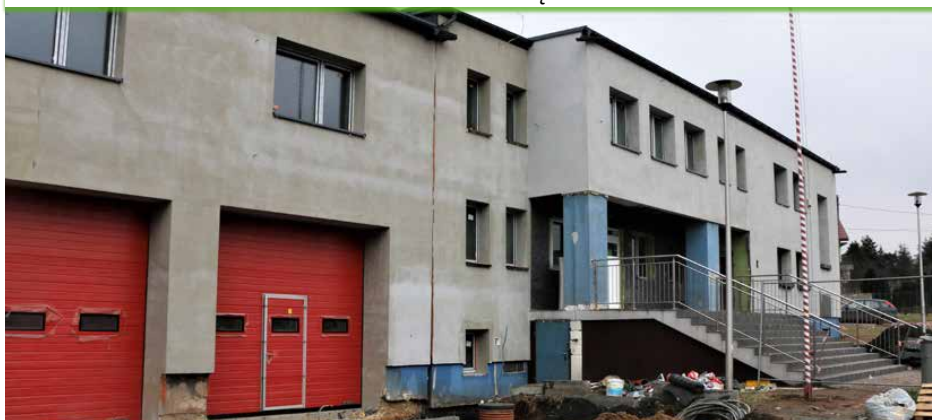
Trwa docieplanie ścian i fundamentów budynku
