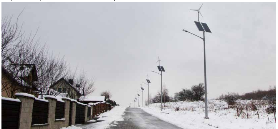
Oświetlenie hybrydowe na ul. Irysów w Psarach
