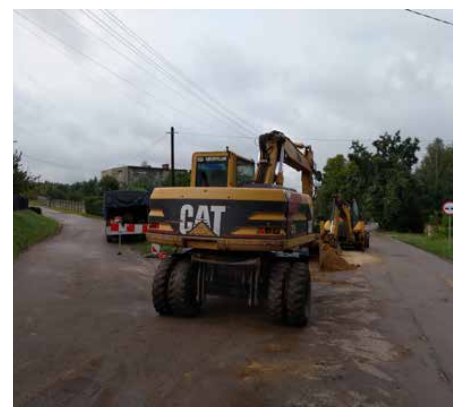
Prace budowlane przy budowie chodnika.
