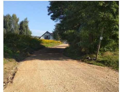
Goląsza, droga za byłą wspólnotą gruntową.
