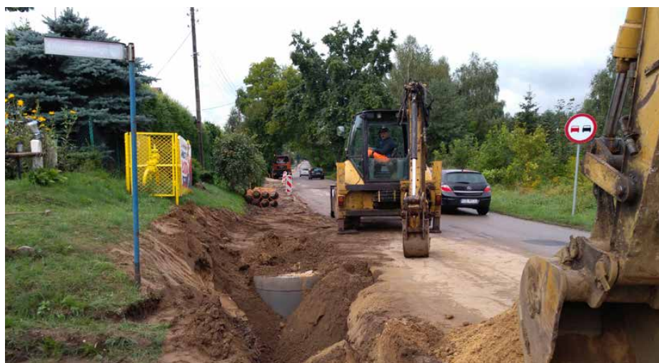
Prace przy skrzyżowaniu ulicy Kościuszki z ulicą Kochanowskiego.
