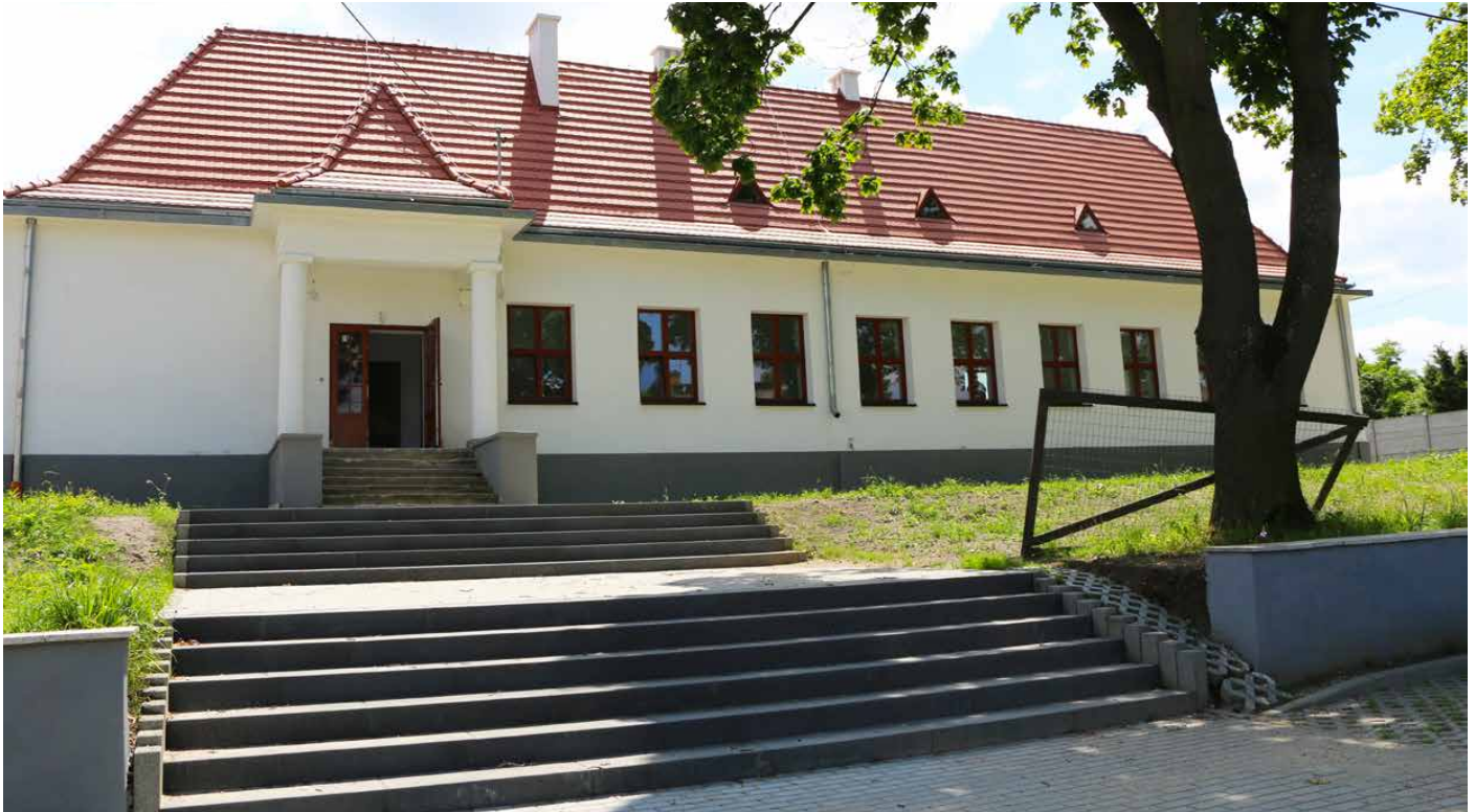
Nowe schody do głównego wejścia budynku.
