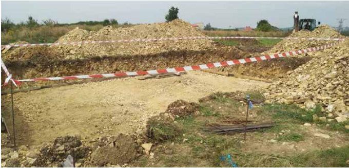
Prace budowlane pierwszego etapu inwestycji.
