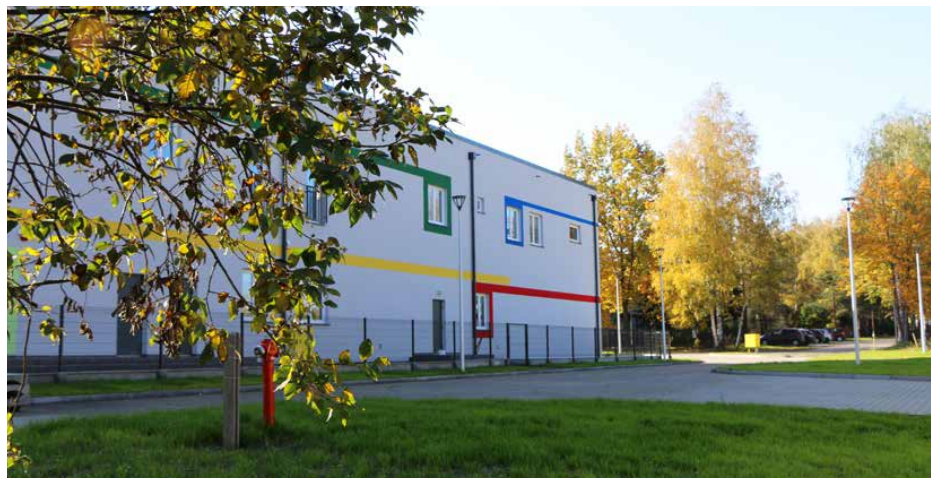
Budynek żłobka w Psarach.
