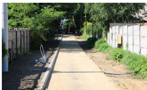
BUDOWA CIĄGU PIESZEGO W GRÓDKOWIE
