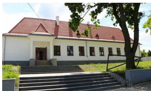
W GOŁĄSZY GÓRNEJ ZAKOŃCZONO PRACE NA ZEWNĄTRZ BUDYNKU
