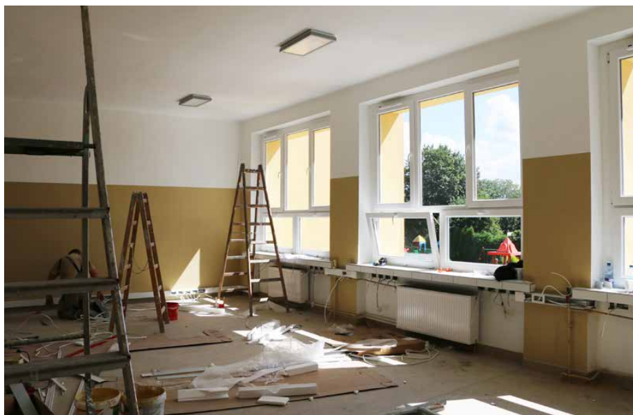
Wykończeniowe prace remontowe w SP Strzyżowice.
