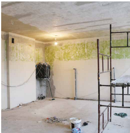
Usuwanie starych tynków.
