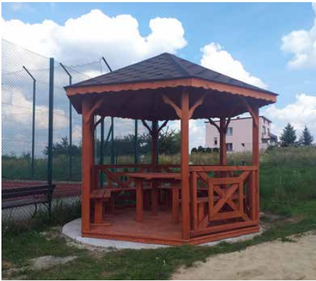
Nowa altana w Górze Siewierskiej.
