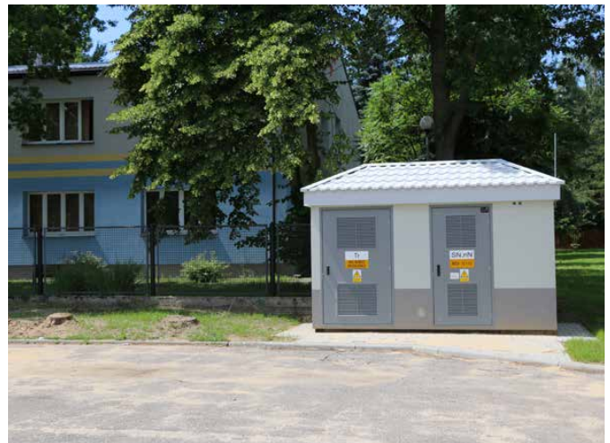
Nowy transformator w Psarach.
