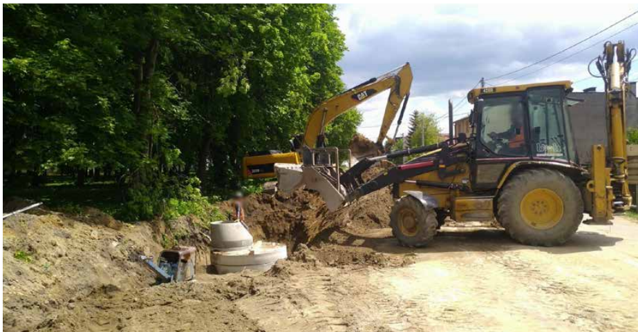
Prace budowlane przy kanalizacji w rejonie ul. 1 Maja w Strzyżowicach
