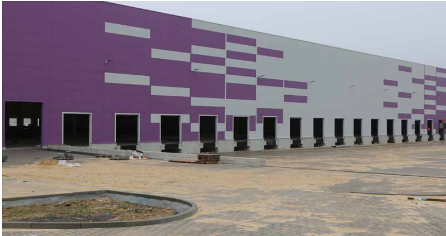
Budowa segmentu 1 zakończy się w sierpniu tego roku
