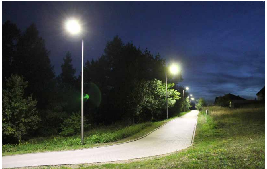
Lamy zostały zamontowane na 230 m odcinku drogi
