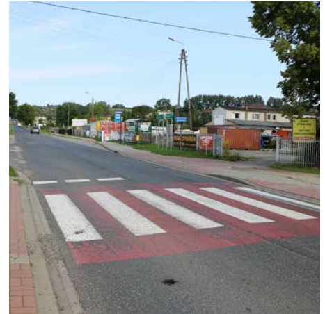
We wrześniu ruszyła przebudowa DW 913
