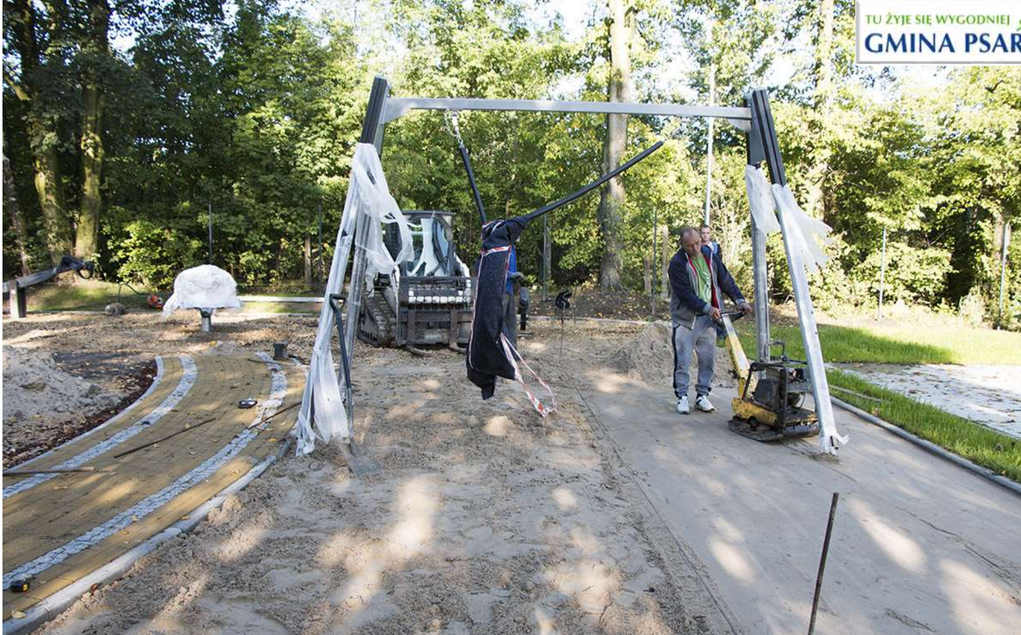
Prace przy budowie placu zabaw.
