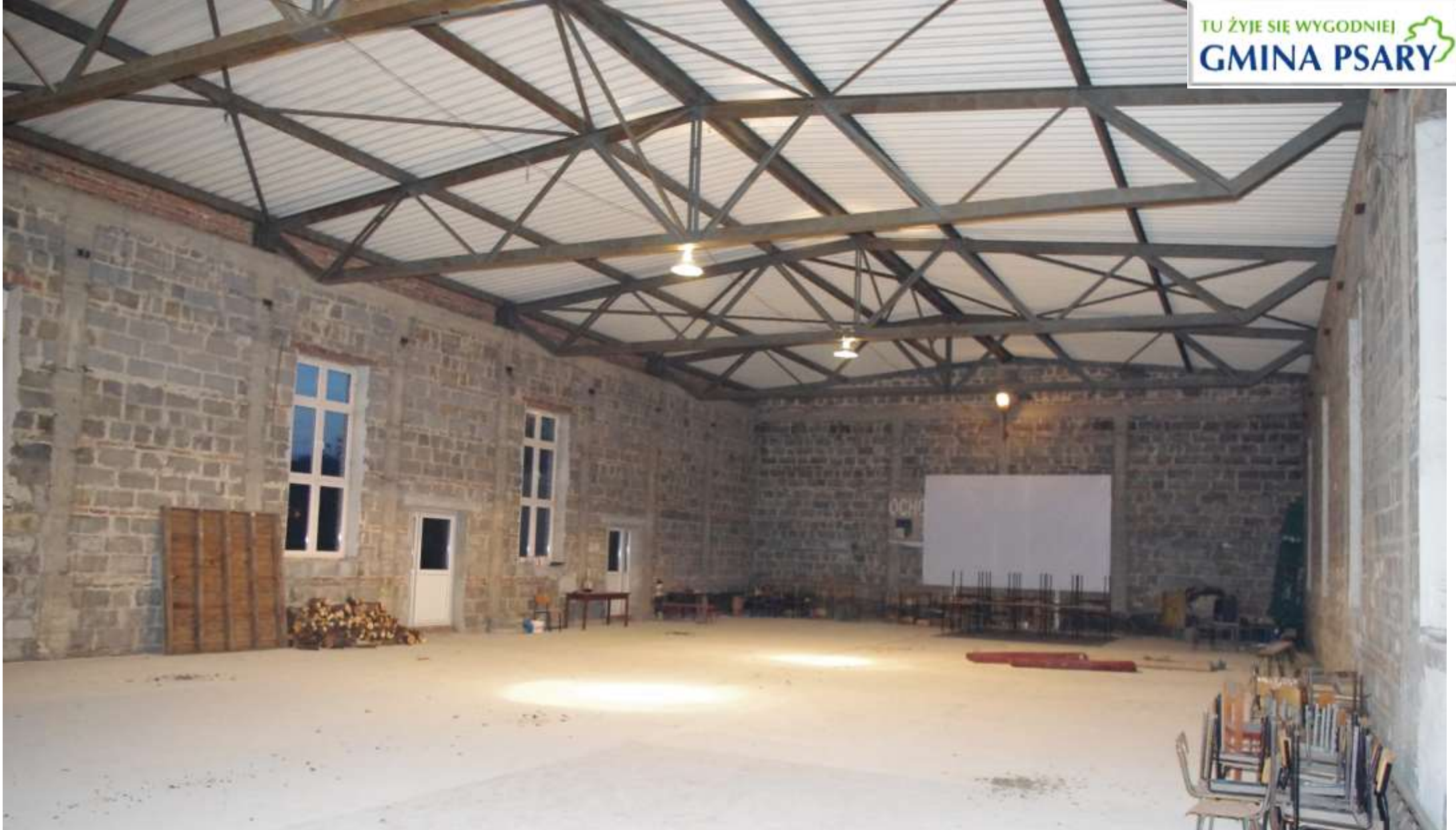
Stan przed rozpoczęciem inwestycji.
