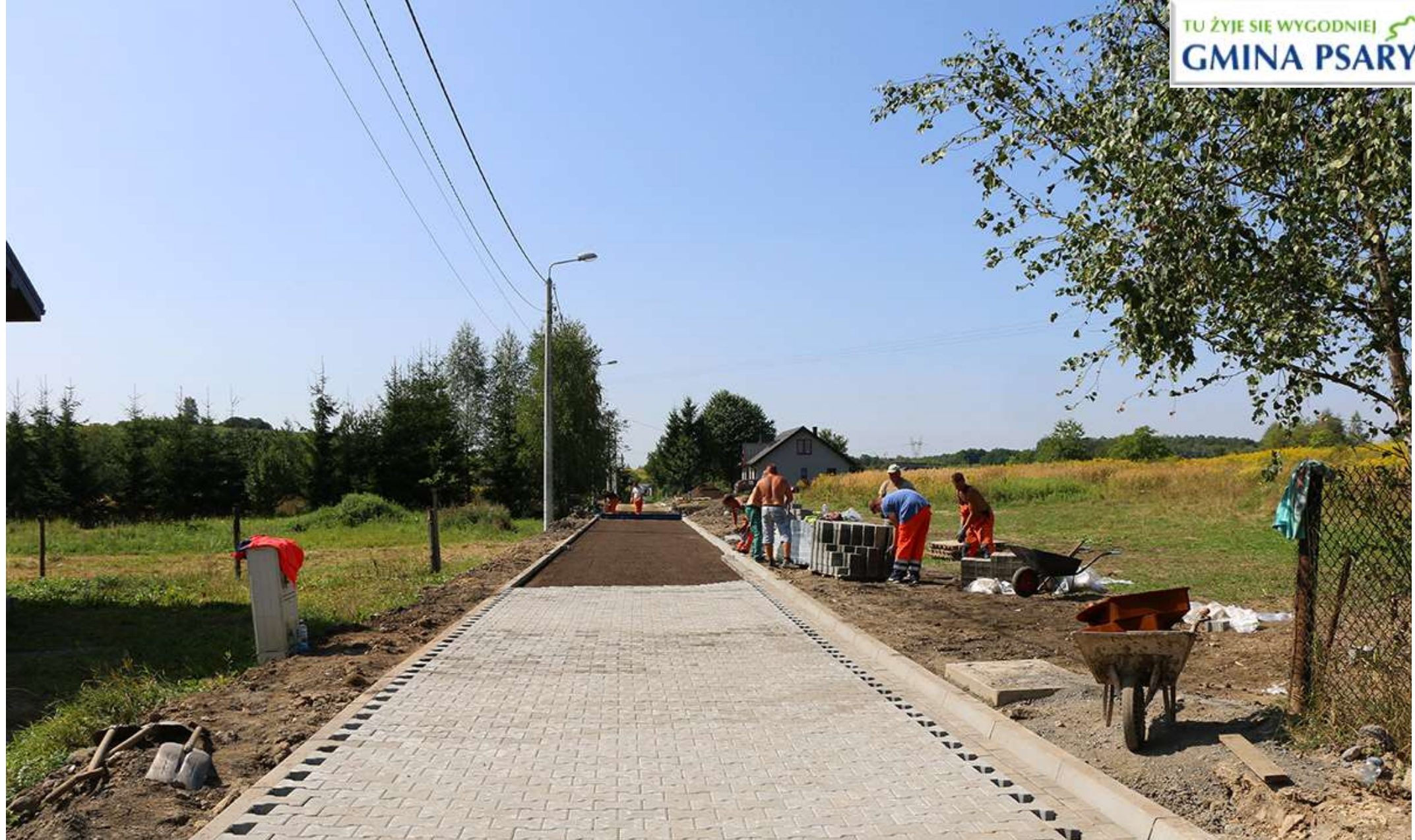
Prace rozpoczęły się wiosną 2017 roku.
