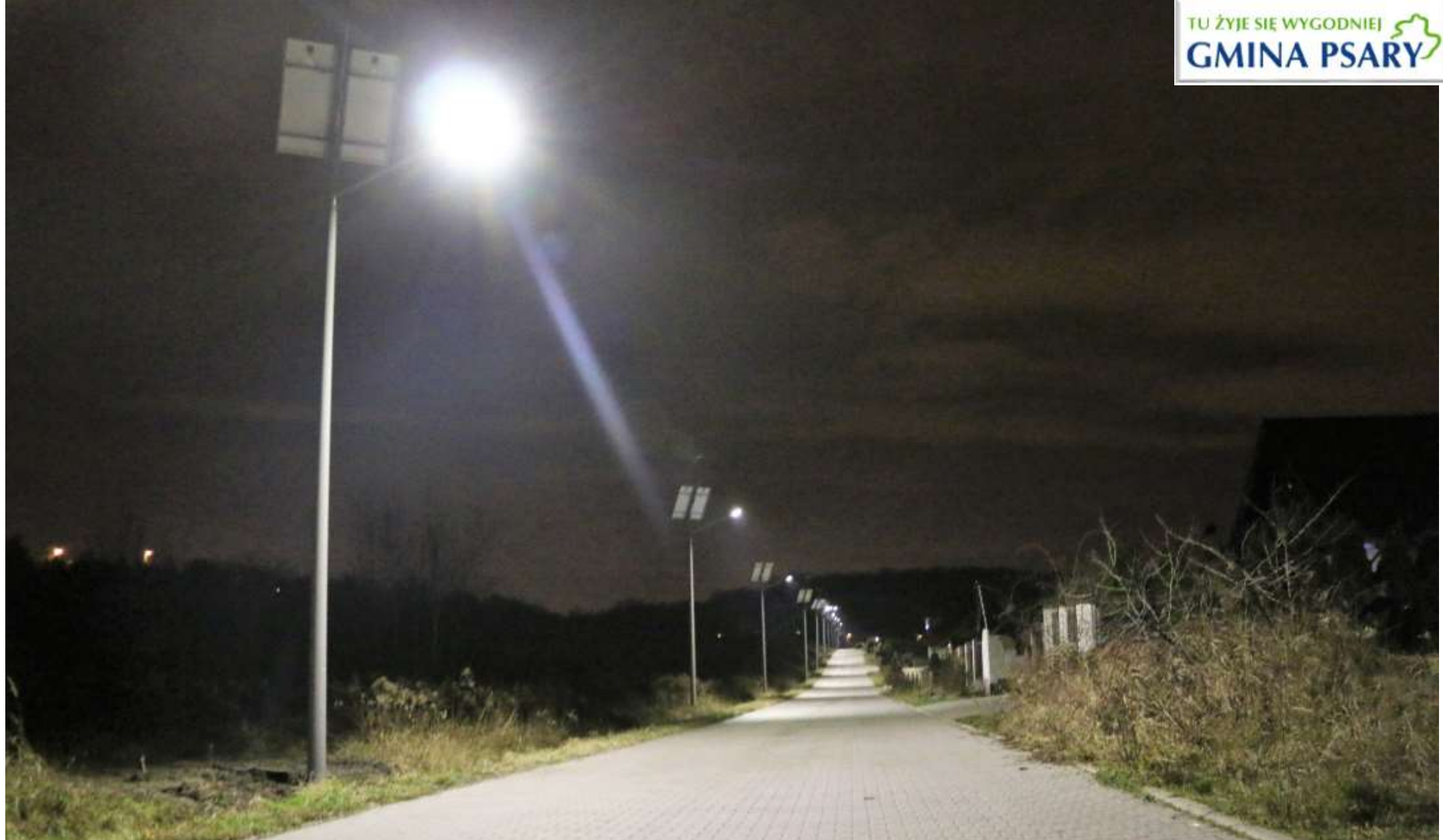
Oświetlenie hybrydowe na ul. Irysów w Psarach.
