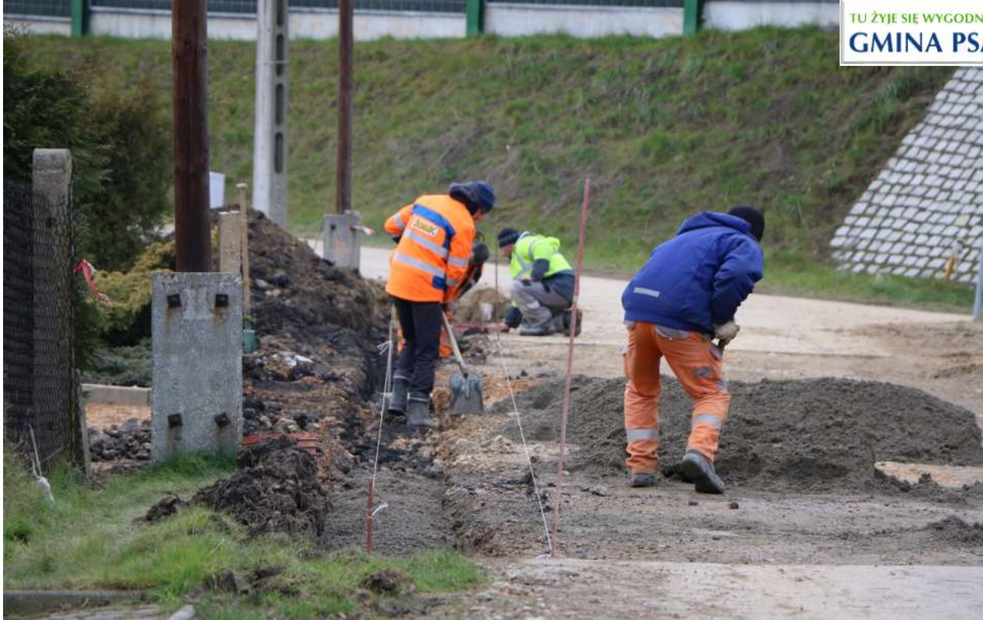
Budowa odwodnienia ul. Podgórznej w Sarnowie – koszt: 326 652 zł.
