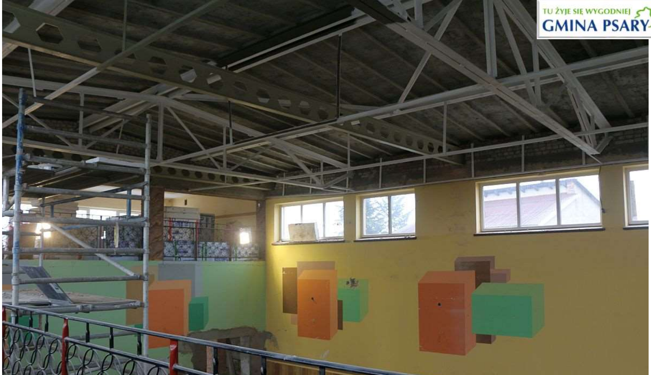
Wzmocniono konstrukcję dachu.
