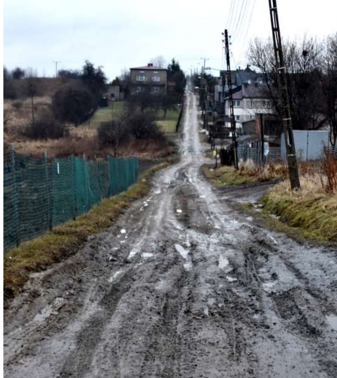
Stan przed przebudową drogi – brak odwodnienia uniemożliwił utwardzenie drogi.
