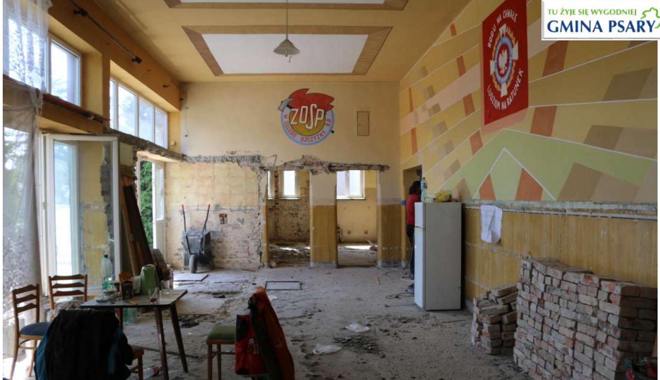
Prace rozbiórkowe w holu.
