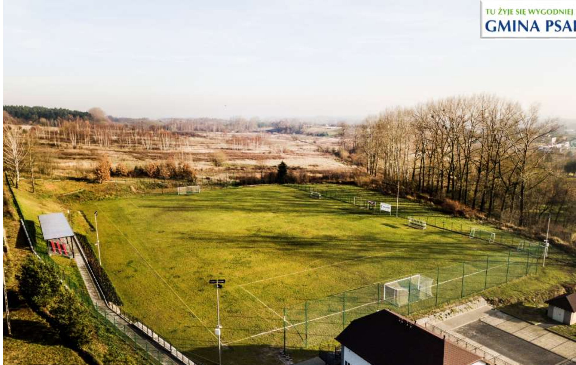
Przebudowany stadion z lotu ptaka – widoczne oświetlenie sportowe umożliwiające treningi po zmroku.
