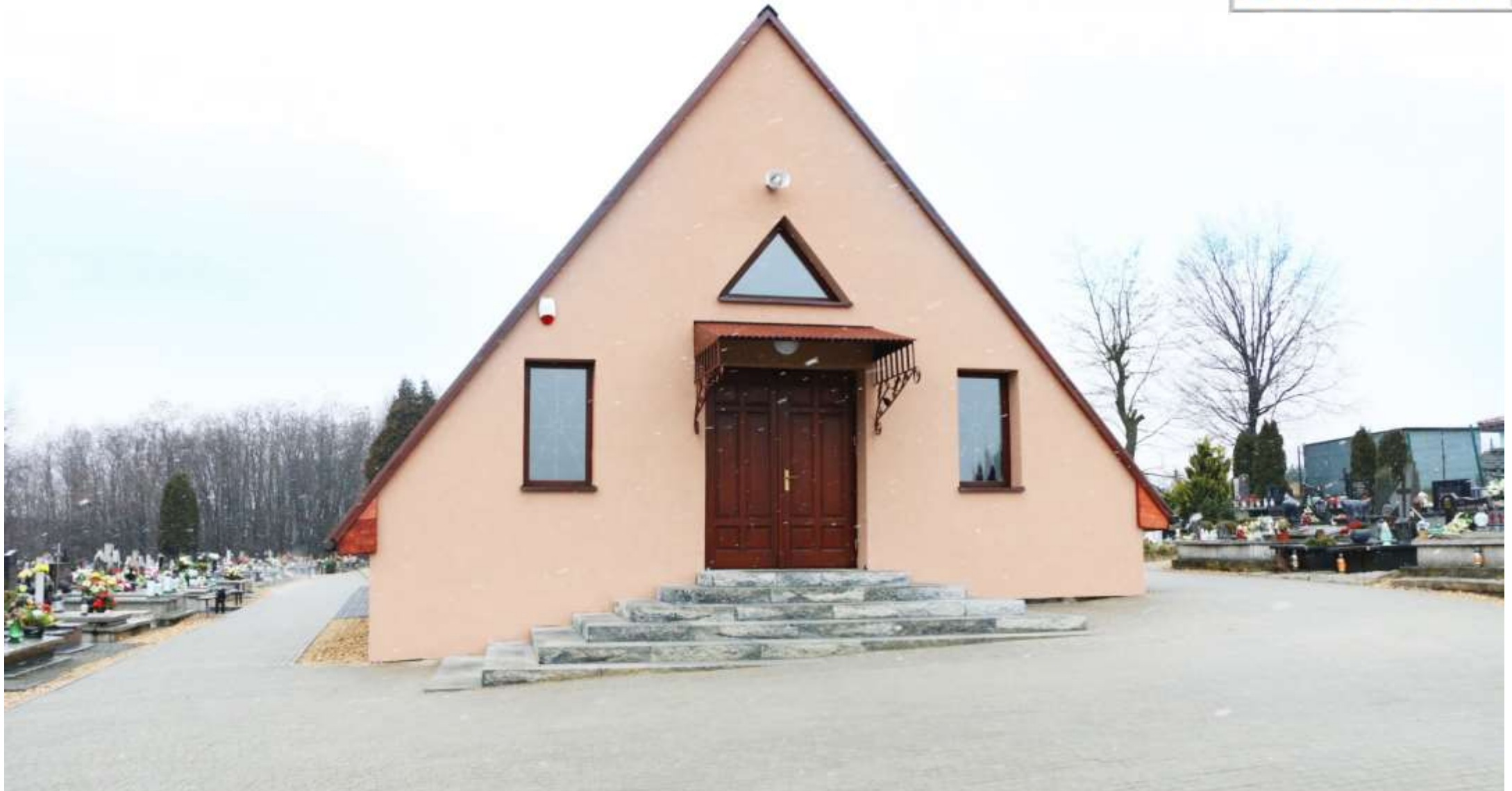
Kaplica po remoncie wykonanym przez ZGK.
